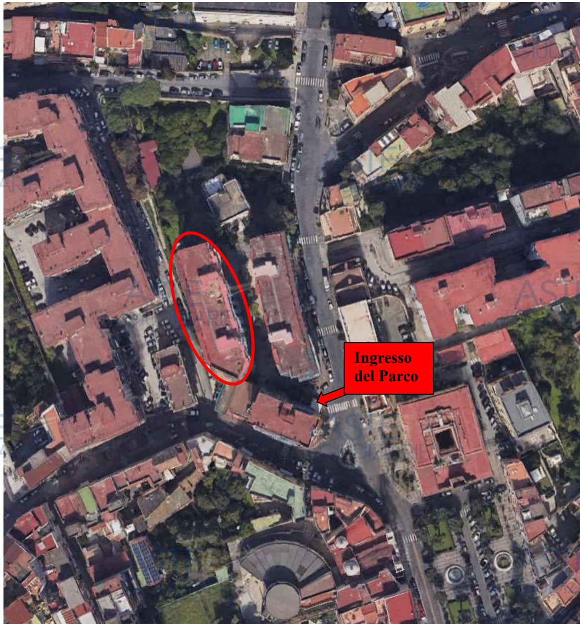
Immagine satellitare del fabbricato in San Giorgio a Cremano (NA) - Via Alcide De Gasperi, 13
