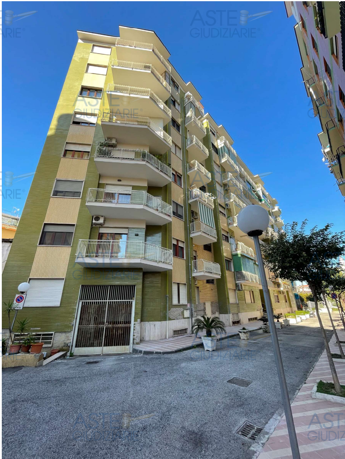
Fabbricato Ovest. Prospetto sul viale privato
