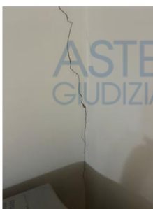
Foto n. 53 - Camera n.2 - particolare delle lesioni
