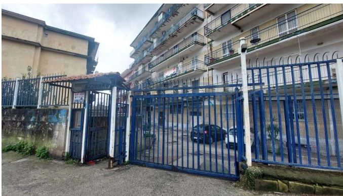
Portone d'accesso al fabbricato da via Evangelista Torricelli
