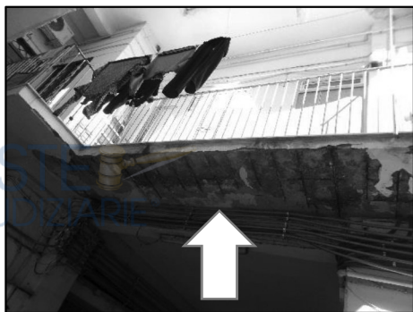
Dettagli della soletta in corrispondenza dei sub 5 e 6
