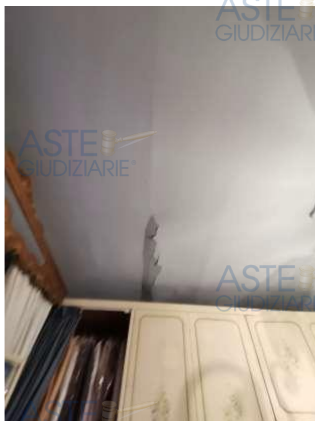
n°03 (tre) foto della camera da letto con evidenza delle cavillature al soffitto.
