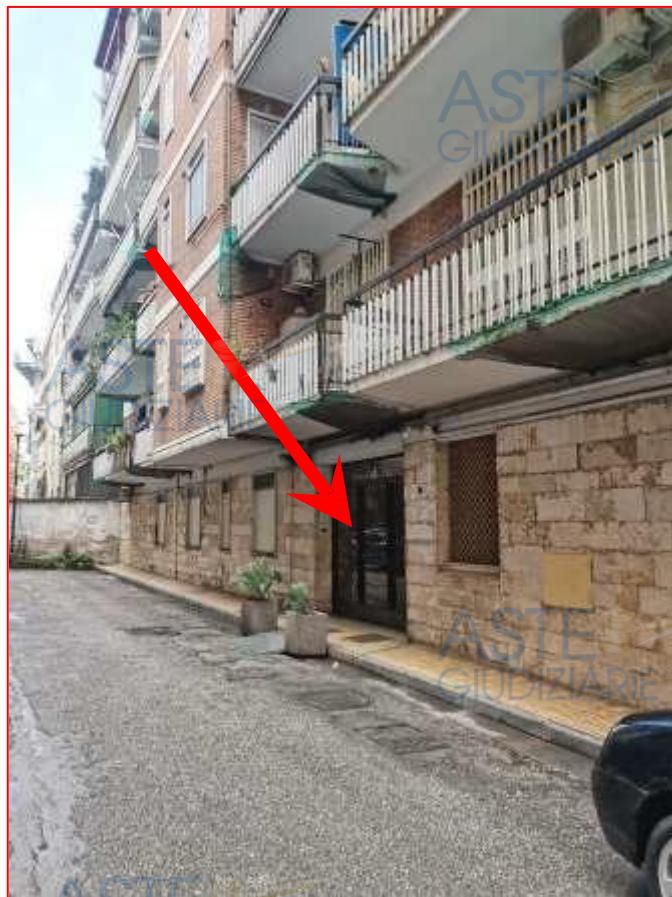
Foto 2: ingresso del palazzo dalla Traversa III detta Maglione
