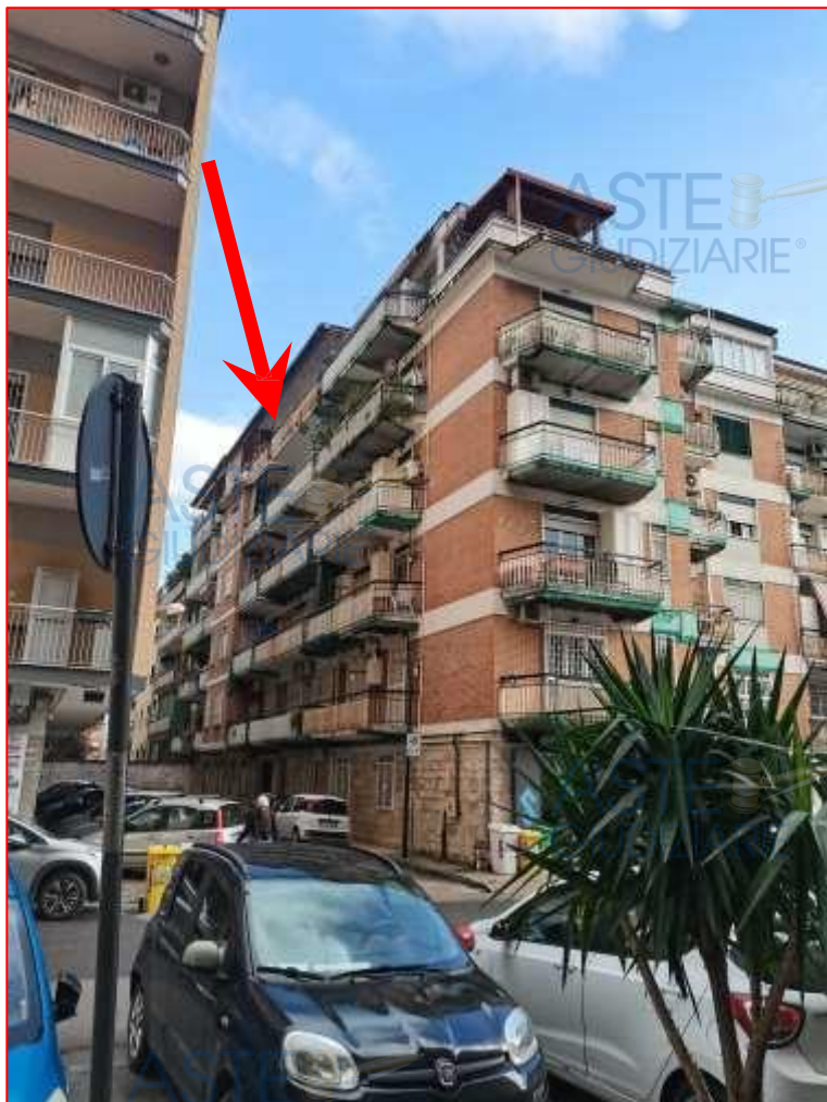
Foto 1: vista del palazzo ove è ubicata l'u.i. staggità (vedasi freccia).
