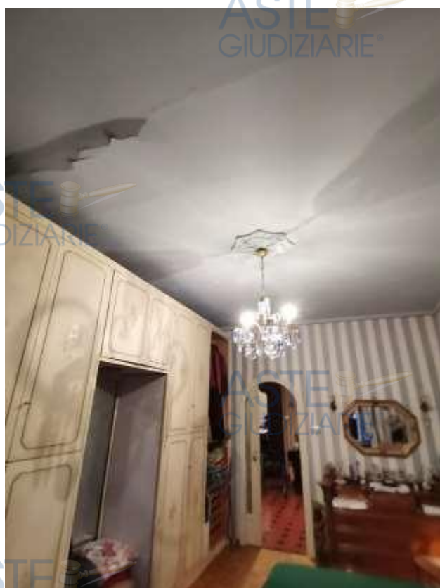
n°03 (tre) foto della camera da letto con evidenza delle cavillature al soffitto.
