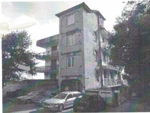
Veduta esterna del fabbricato da Viale Privato con accesso da Via Sartania 55
