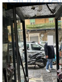
Foto n. 4 - Ingresso verso la strada
