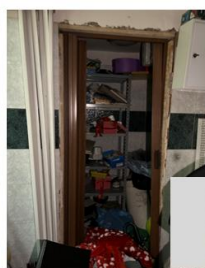
Foto n. 24 - Locale wc verso l'interno del locale
