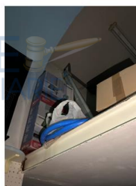
Foto n. 12 - Ambiente n.1 verso il soppalco
