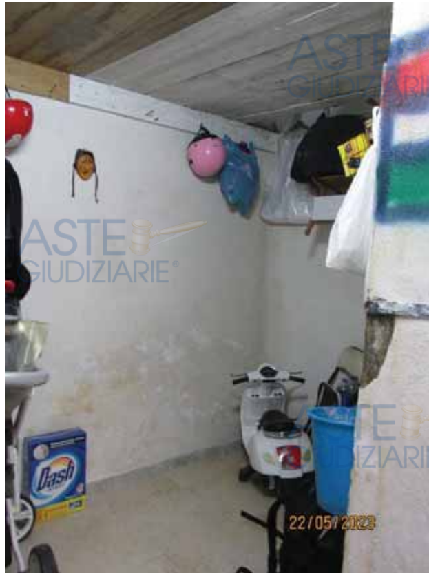
Fotografia 49 – Locale Deposito : le pareti sono rivestite da intonaci ordinari a finitura liscia e tinteggiate con pittura lavabile; il soffitto del solaio si presenta a botte e risulta interamente rivestito con intonaci ordinari e tinteggiato con pittura a tempera.
