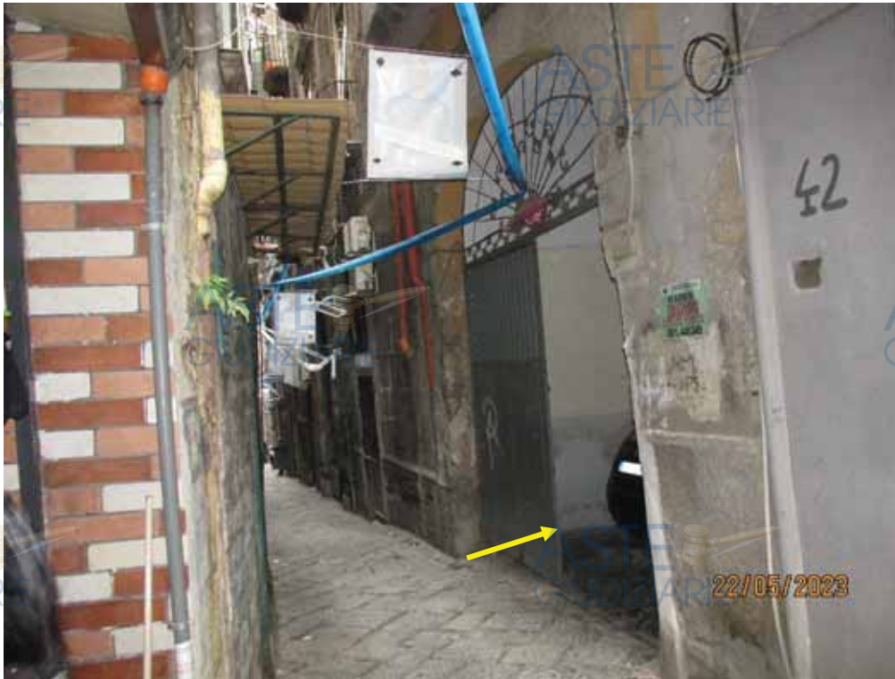
Fotografia 10 – Vista ingresso al fabbricato da Vico Maiorani civ. 41.
