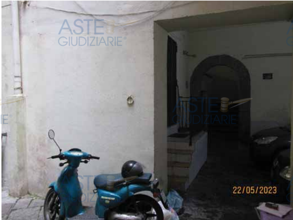
Fotografia 15 – Il cortile condominiale risulta scoperto per consentire l'accesso di luce naturale, è interamente pavimentato con basoli pesanti in piperno e presenta i prospetti del fabbricato rivestiti con intonaci ordinari tinteggiati con pittura al quarzo. Il cortile viene utilizzato come parcheggio per motocicli e consente l'accesso al Deposito pignorato distinto al Sub. 35.
