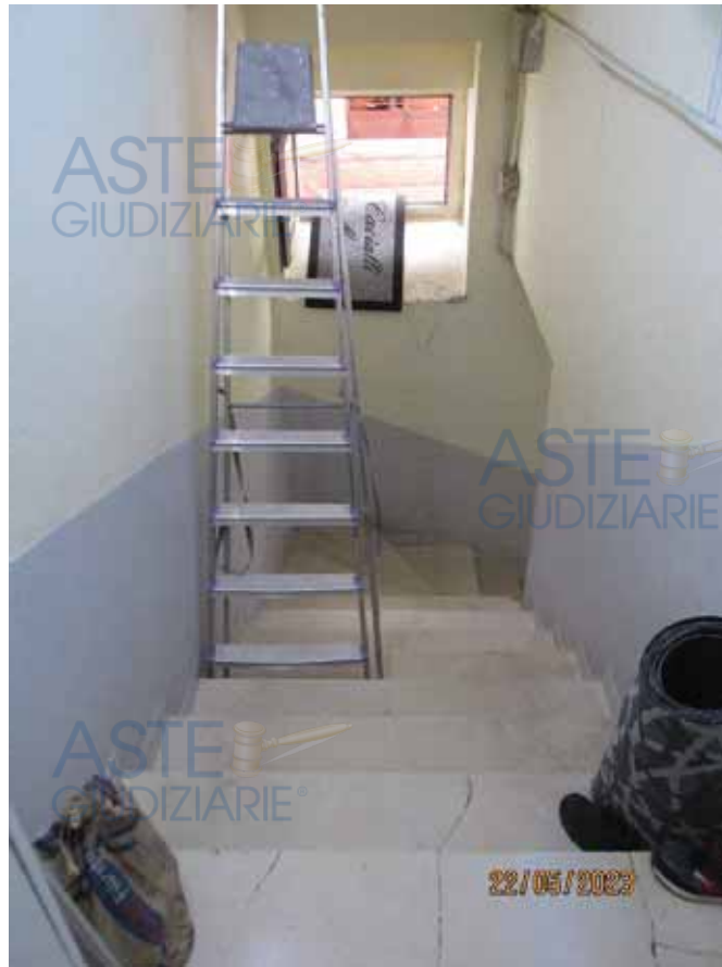
Fotografia 52 – Lastrico Solare: Per accedervi bisogna posizionare una prima scala portatile sui gradini della scala condominiale in prossimità del terzo piano.
