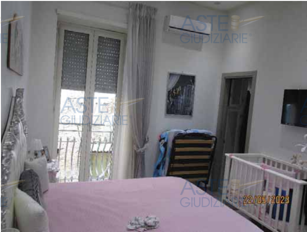
Fotografia 42 – Vano 3: L’ambiente è dotato di una porta-finestra con aggetto alla “romana” da cui prende aria e luce, è protetto esternamente da una ringhiera in ferro ed internamente di infisso in alluminio con vetri camera, la finestra affaccia su Vico dei Maiorani.
