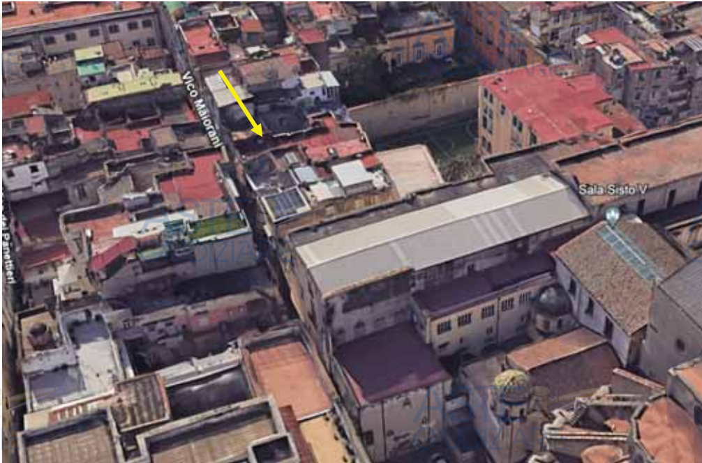
Fotografia 3 – Inquadramento territoriale lato Nord.
