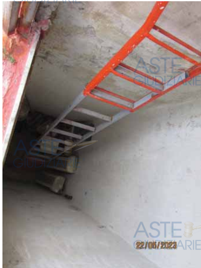
Fotografia 54 – Lastrico Solare : Giunti al ballatoio del torrino in muratura è necessario posizionare un'ulteriore scala portatile.
