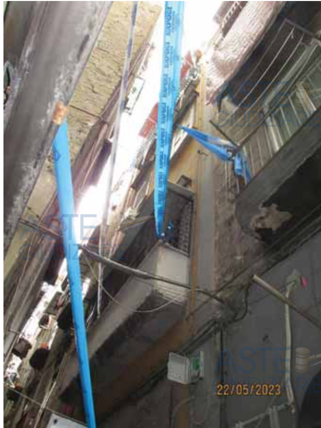
Fotografia 9 – Vista fabbricato da Vico Maiorani.
