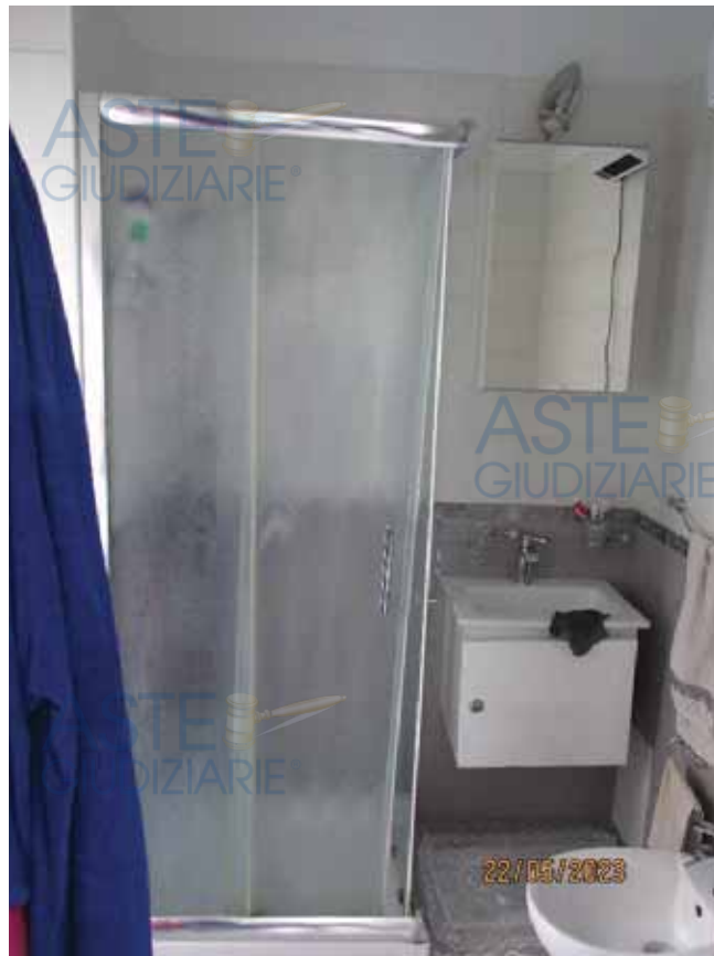
Fotografia 45 – Bagno 2: Vi si accede dal “Vano 3”, occupa una superficie utile netta pari a mq. 2,70 ed un'altezza dal piano di calpestio di ml. 3,60. L'ambiente è dotato di tazza igienica, lavabo, bidet e cabina doccia. La pavimentazione è costituita per tutta la sua superficie da piastrelle in ceramica smaltata; le pareti sono rivestite con piastrelle di ceramica smaltata fino ad un'altezza di circa ml 2,20 dal piano di calpestio, mentre la restante parte risulta rivestita con intonaci ordinari a finitura liscia tinteggiate con pittura lavabile.
