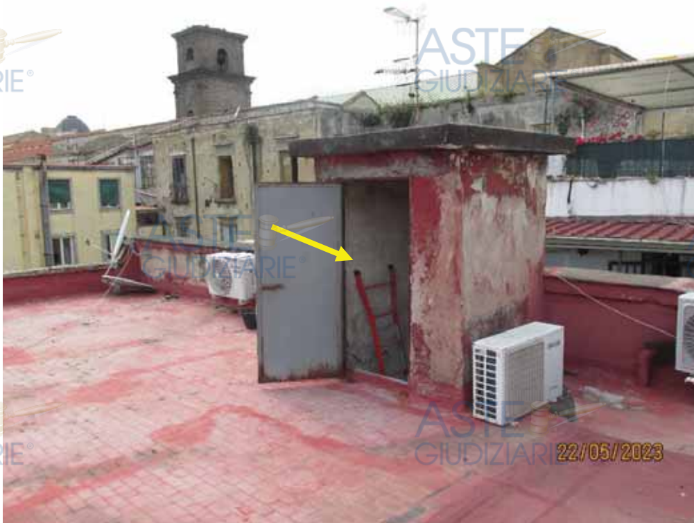
Fotografia 55 – Lastrico Solare: il torrino in muratura è dotato di due serramenti in ferro di protezione, uno installato alla base, quindi sul ballatoio, e l'altro installato al vertice, quindi sul terrazzo.
