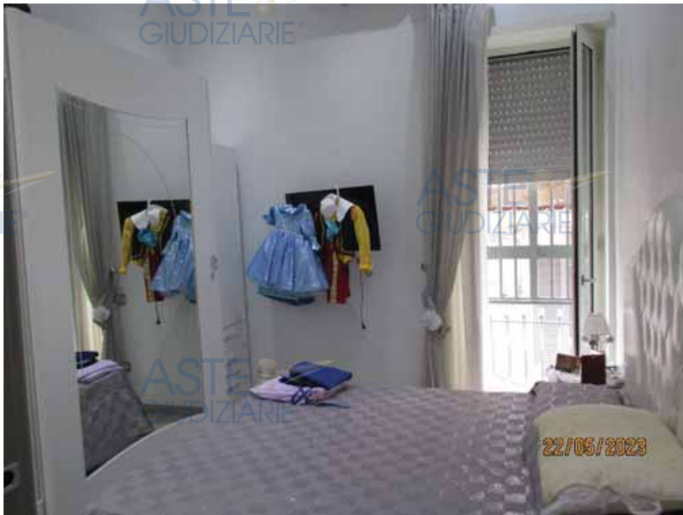
Fotografia 28 – Vano 1: La pavimentazione è costituita da piastrelle in gres porcellanato; le pareti sono rivestite con intonaci ordinari a finitura liscia e tinteggiate con pittura lavabile; il soffitto è rivestito anch’esso con intonaci ordinari a finitura liscia, tinteggiato con pittura a tempera.
