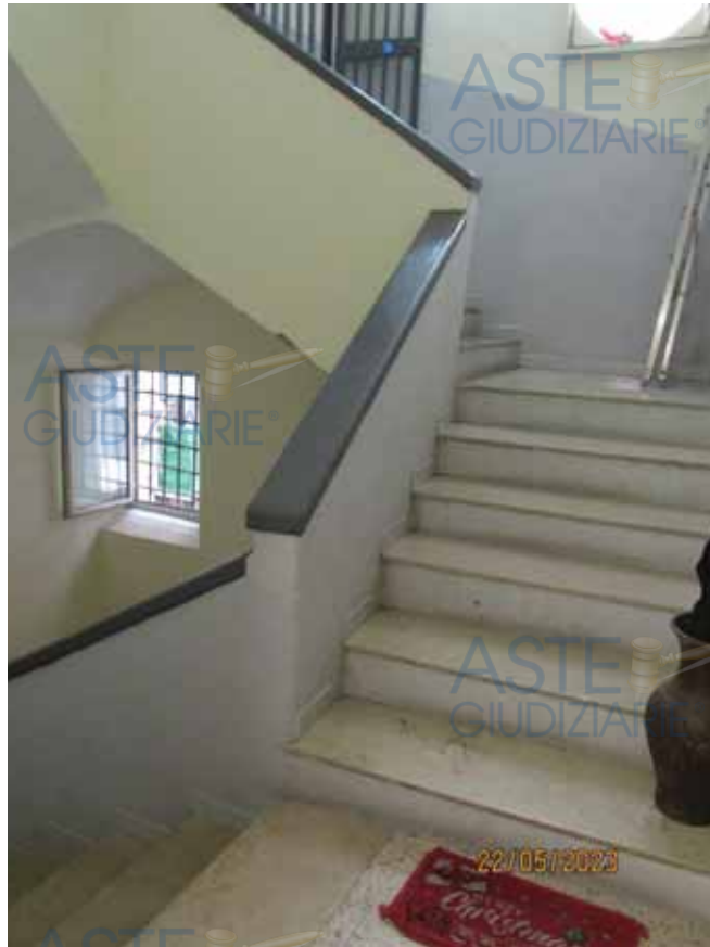
Fotografia 20 – Il vano scala è dotato di finestre protette esternamente da grate in ferro e internamente da serramenti in alluminio con vetrate, per garantire il riciclo dell'aria e l'ingresso di luce naturale.
