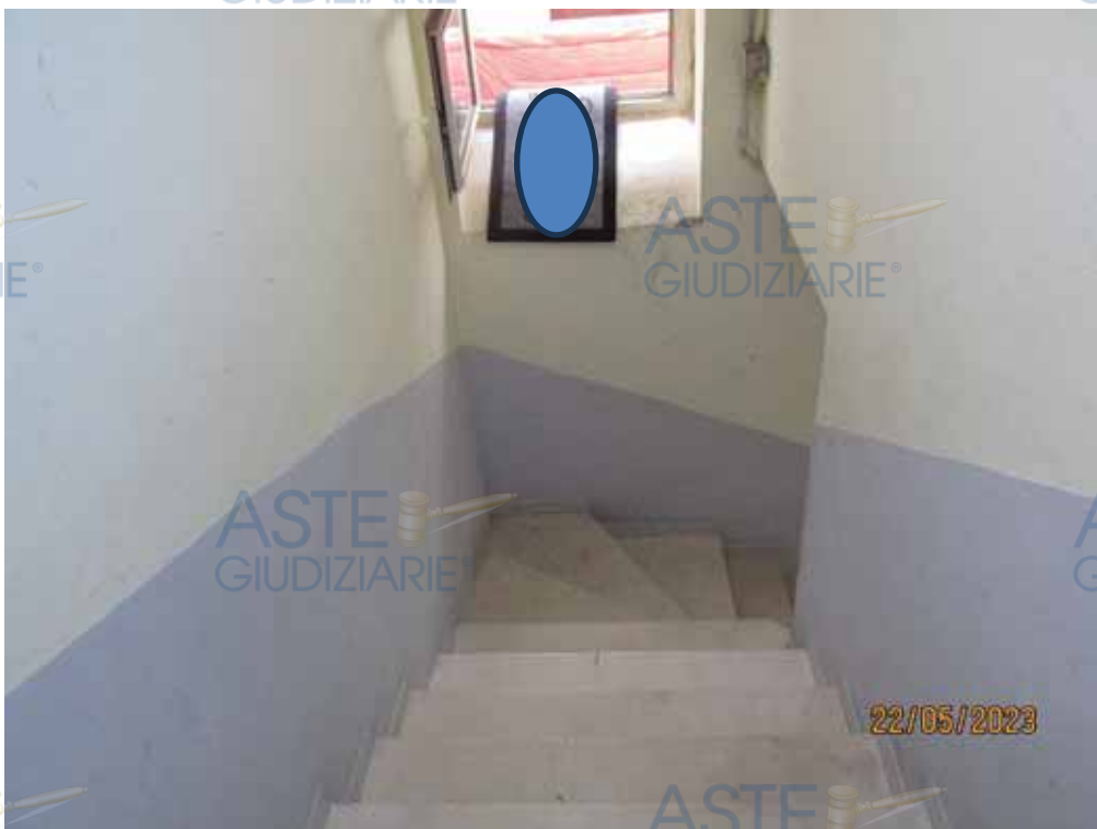
Fotografia 19 – Le pedate fino dal secondo ballatoio in avanti, sono rivestite con lastre in marmo; le pareti del vano scala sono rivestite conintonaci ordinari a finitura liscia e tinteggiate con pittura al quarzo.
