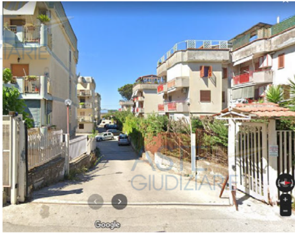
varco ingresso box in via Dorando Pietri, 4, Quarto(NA)
