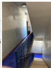
Foto n. 5 - Vano scala del fabbricato
