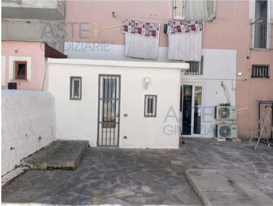
Foto n. 7: • Zona addossata alla porta-finestra di accesso dal locale riconoscibile come di proprietà del cespite. • Si arguisce la natura “aggiunta” del corpo di fabbrica dei servizi.
