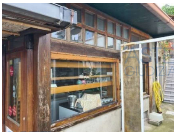
Vista 6 Scala accesso all'immobile sovrastante
