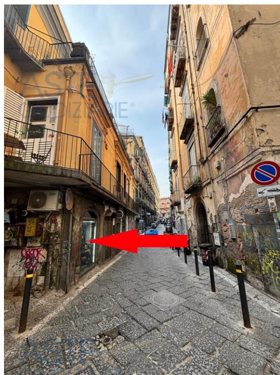
Vista portone di ingresso allo stabile
