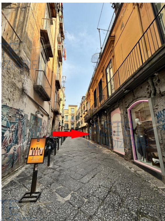
Vista stabile in cui è allocato il cespite
