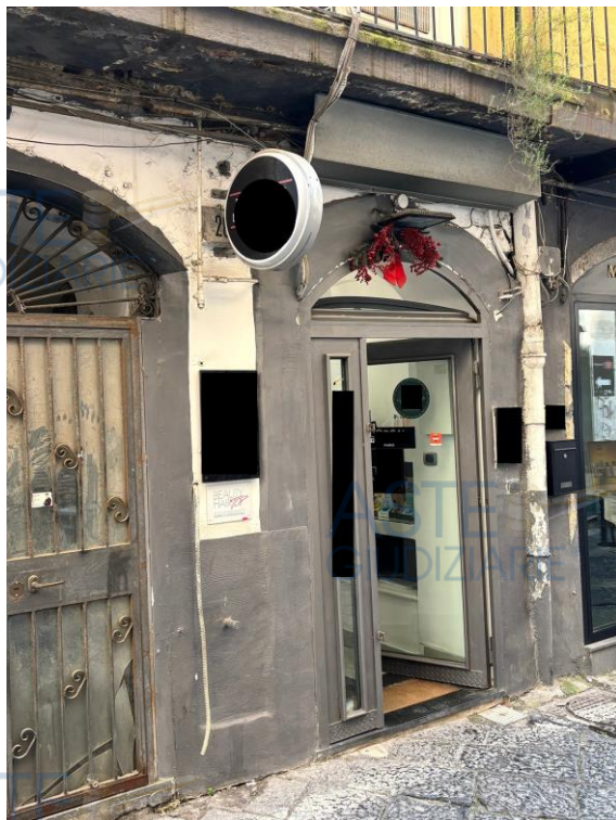
Accesso al locale da altro immobile non oggetto della procedura
