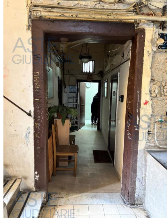
Pianerottolo di smonto secondo piano Per accesso al bene
