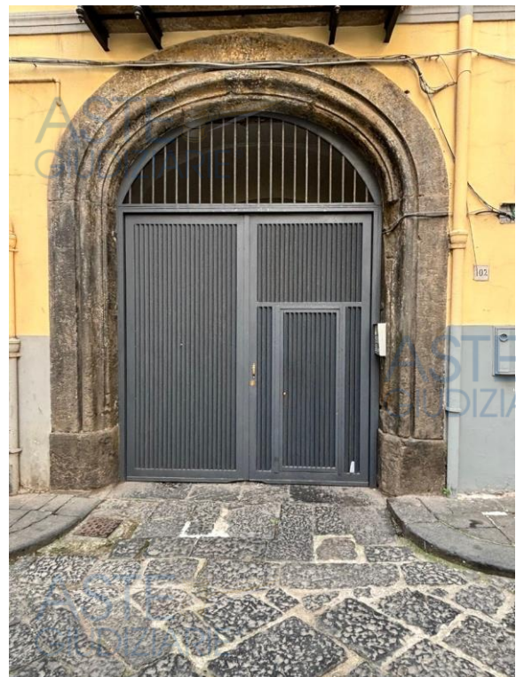
Vista portone di ingresso allo stabile
