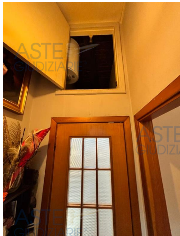
Vista locale disimpegno
