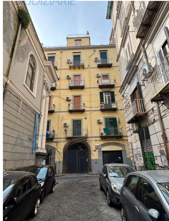
Vista Rua Catalana
