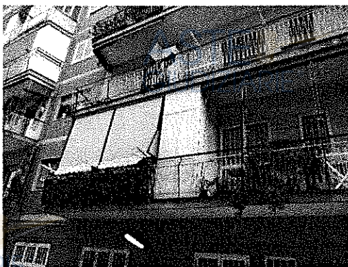
BALCONE LATO SUD
