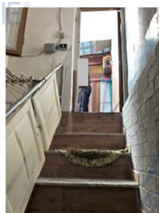
Foto n. 43 - Vano scala di accesso al terrazzo
