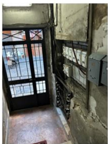
Foto n. 2 - Fabbricato - vano scala
