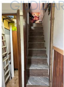
Foto n. 41 - Vano scala di accesso al terrazzo
