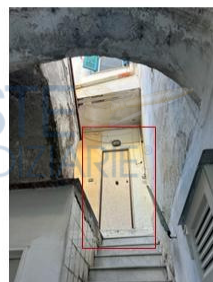
Foto n. 6 - Fabbricato - vano scala - Porta di ingresso al cespite
