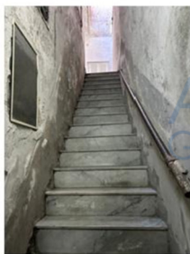
Foto n. 4 - Fabbricato - vano scala
