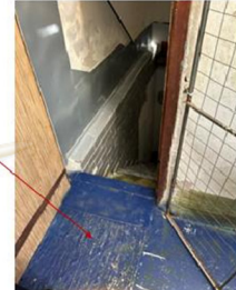
Foto n. 58 - Accesso al terrazzo attraverso porzione di terrazzo di proprietà aliena
