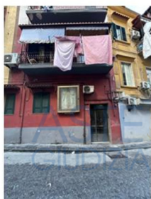
Foto n. 1 - Fabbricato in cui è ubicato l'immobile pignorato
