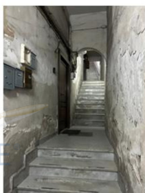
Foto n. 3 - Fabbricato - vano scala
