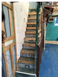
Foto n. 54 - Terrazzo esclusivo - scala di accesso al soprastante terrazzo di proprietà aliena
