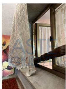
Foto n. 42 - Vano scala di accesso al terrazzo
