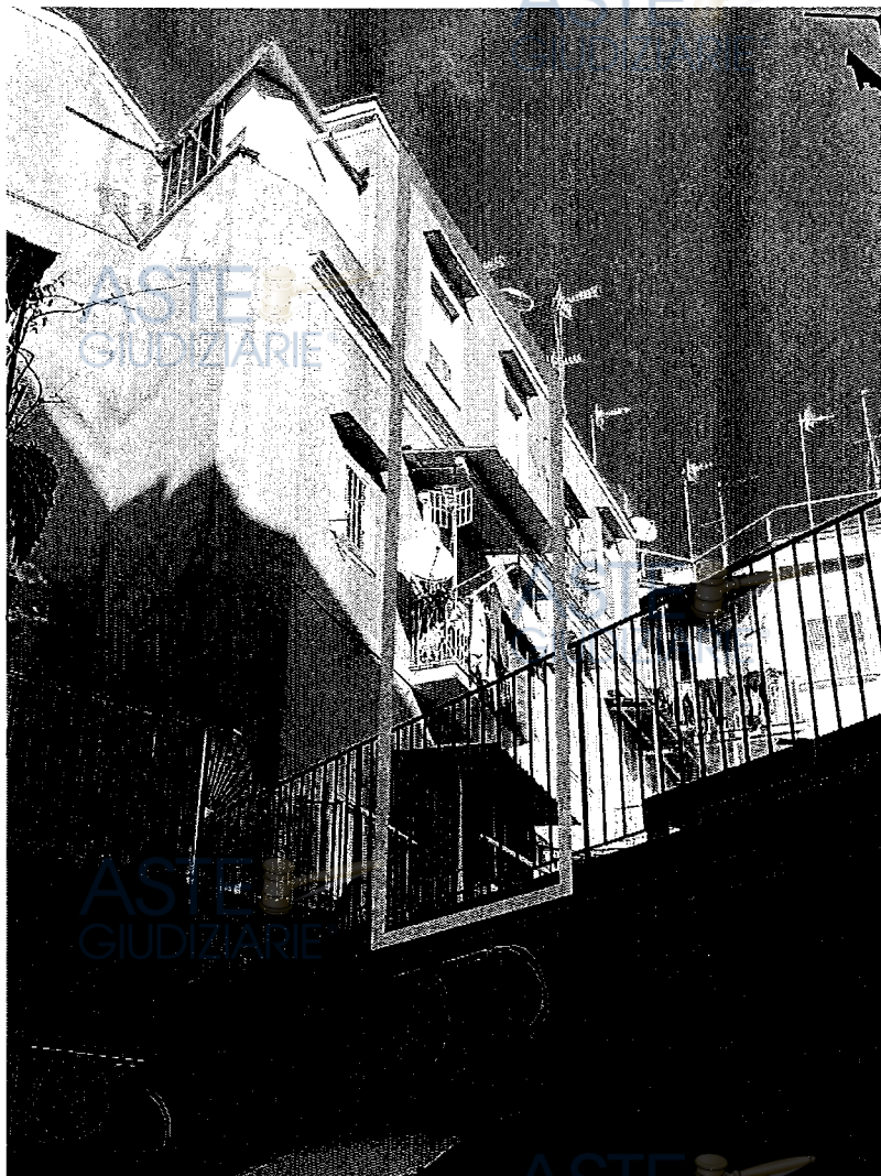
Fronte del fabbricato su cortile condominiale
