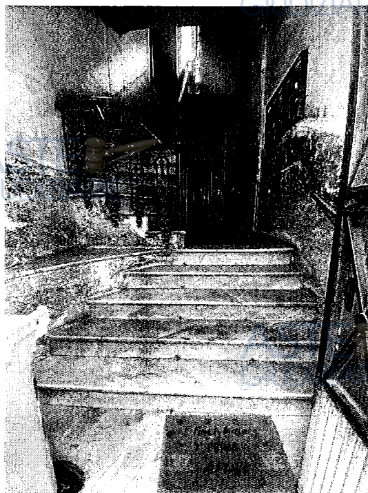
Particolare dall'ingresso al fabbricato
