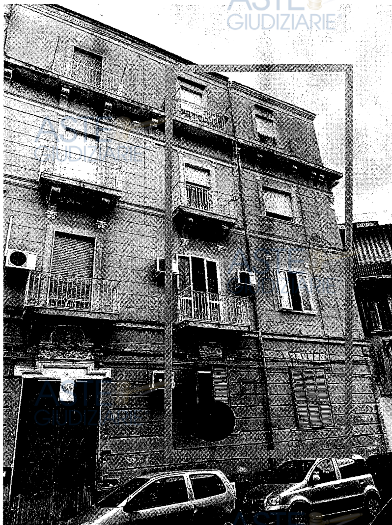
Fronte del fabbricato su Via Giacomo Profumo
