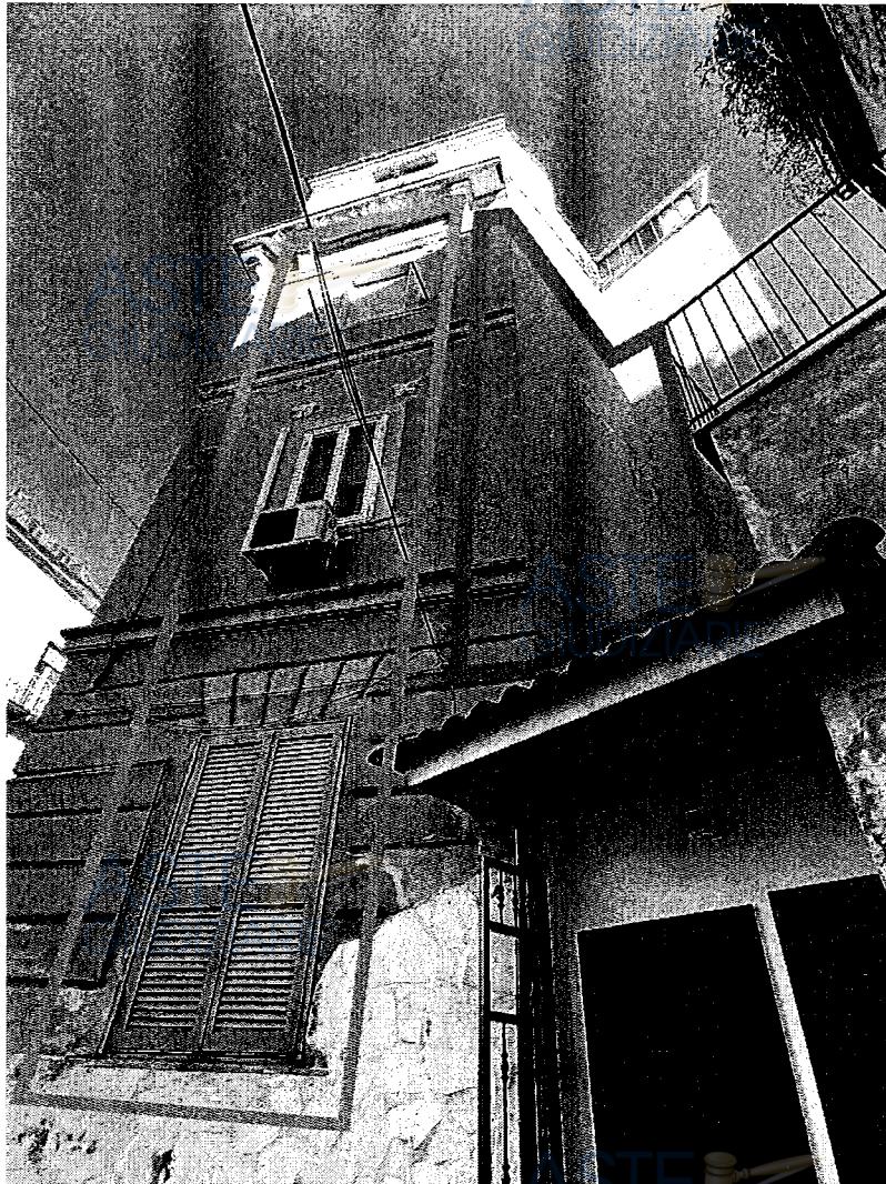
Fronte laterale del fabbricato su via Giacomo Profumo
