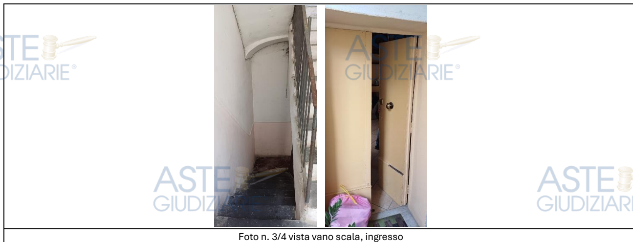
Foto n. 3/4 vista vano scala, ingresso
