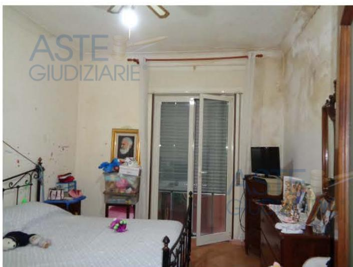
Camera n°1 - particolare di macchie da condensa su pareti laterali e soffitto
