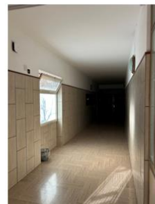
Foto n. 8 - Corridoio d'accesso del fabbricato
