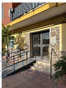
Foto n. 6 - Accesso al fabbricato
