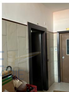
Foto n. 11 - Accesso all'immobile pignorato
