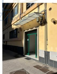
Foto n. 5 - Ingresso al fabbricato
