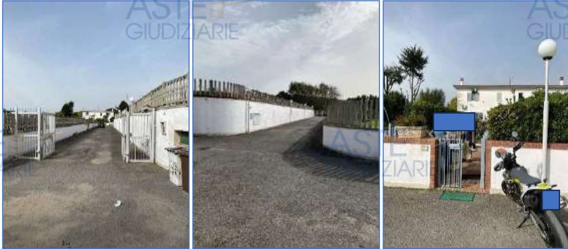
Figura 54. Accesso da via Cuma Licola n. 176 (strada privata).
