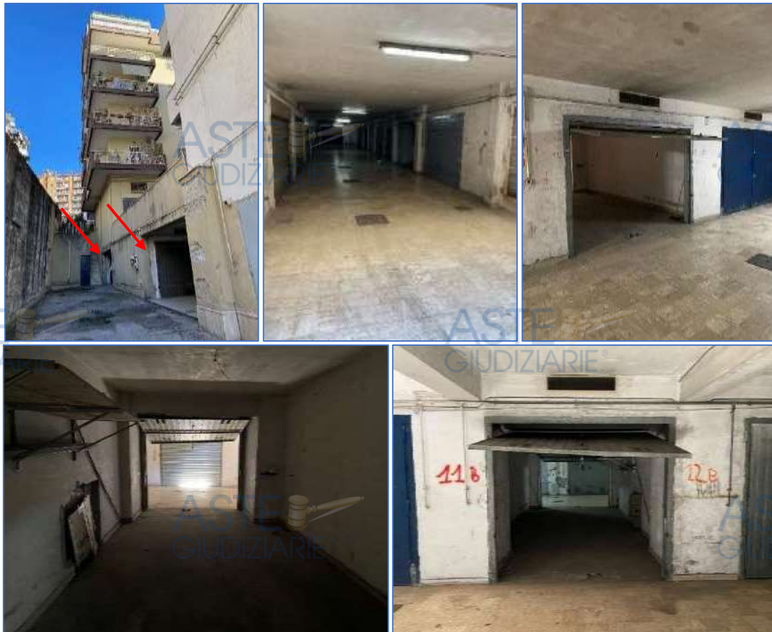
Figura 106. Rilievo fotografico (estratto dell'allegato C-12).
