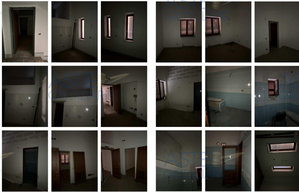
Estratto repertorio fotografico del sub 5
