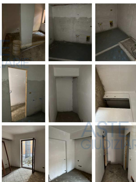
Estratto repertorio fotografico del sub 3
