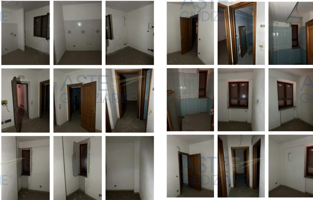
Estratto repertorio fotografico del sub 3
