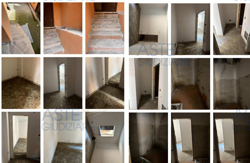
Estratto repertorio fotografico del sub 6
