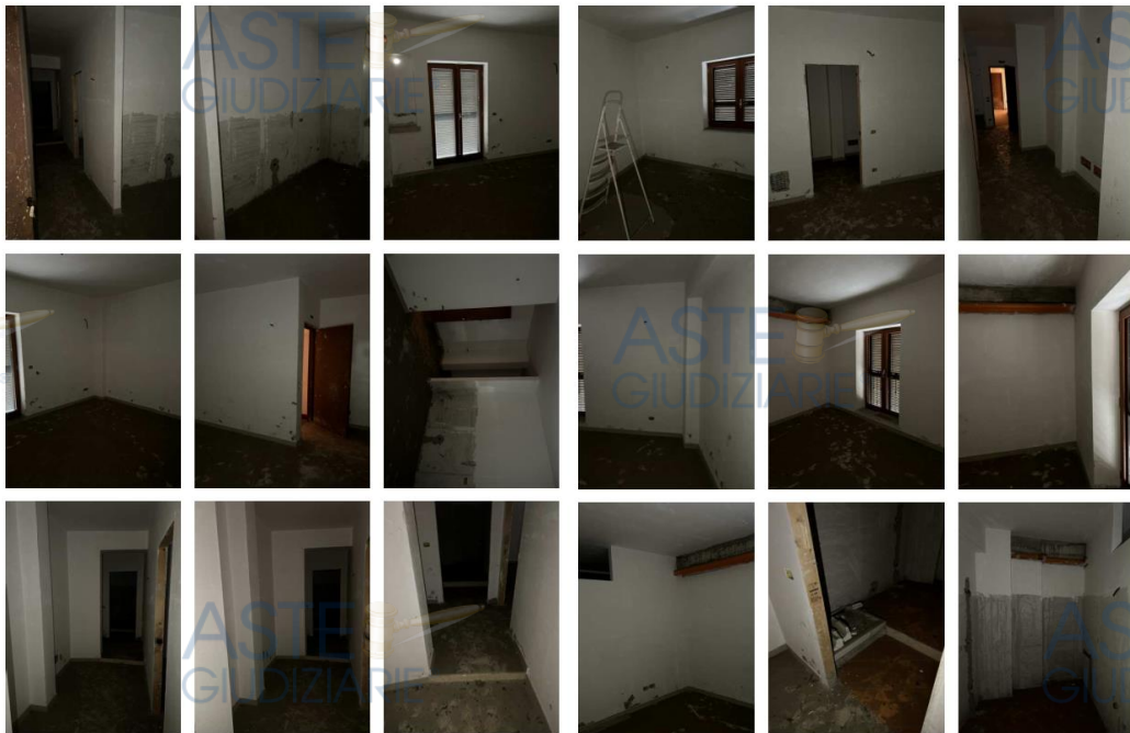
Estratto repertorio fotografico del sub 5
