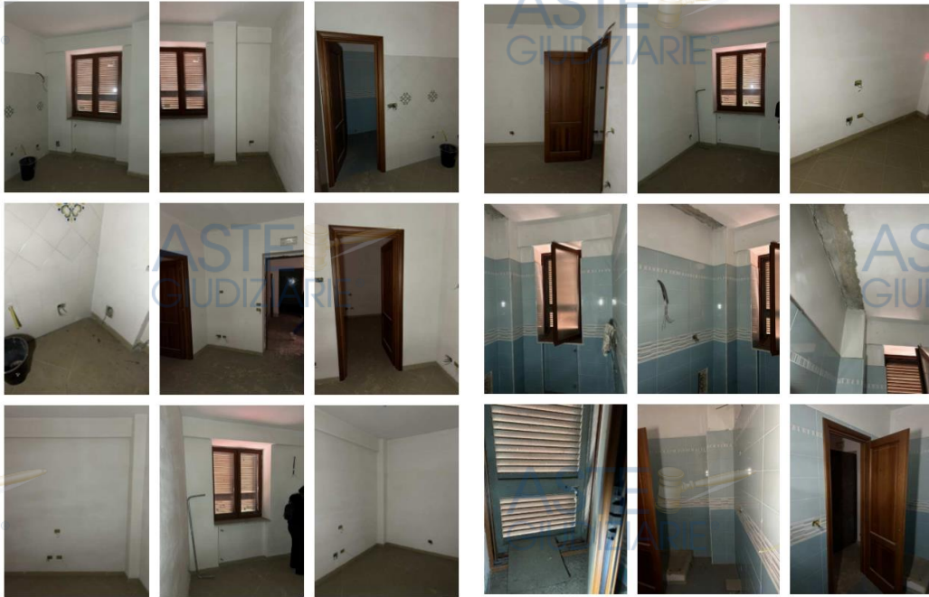
Estratto repertorio fotografico del sub 2
