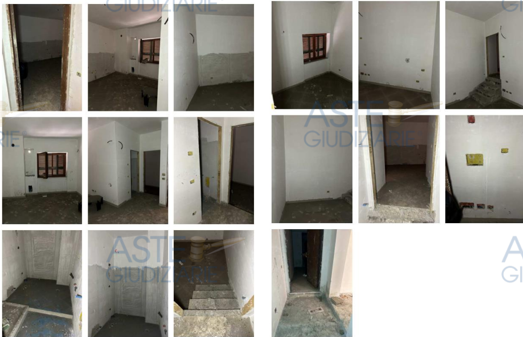
Estratto repertorio fotografico del sub 1
