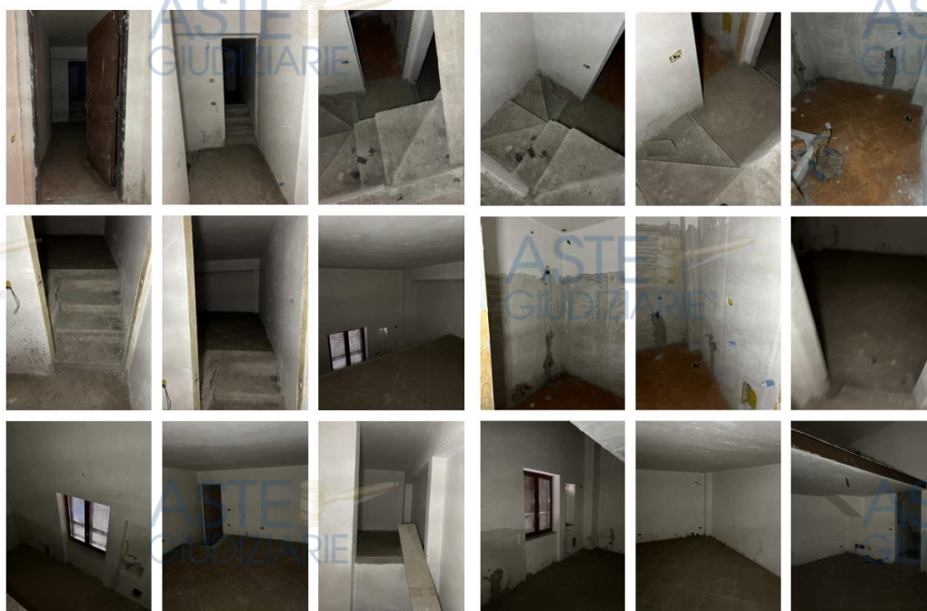
Estratto repertorio fotografico del sub 2
