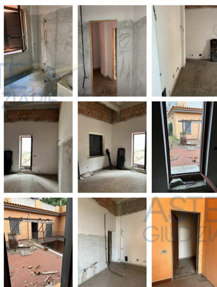
Estratto repertorio fotografico del sub 7
