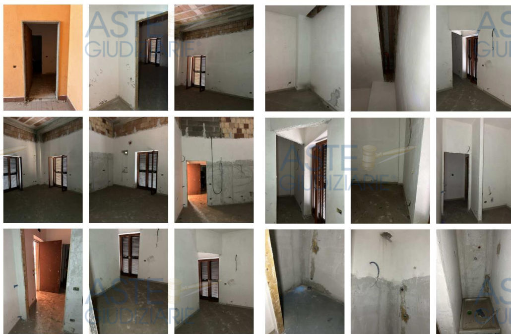
Estratto repertorio fotografico del sub 8
