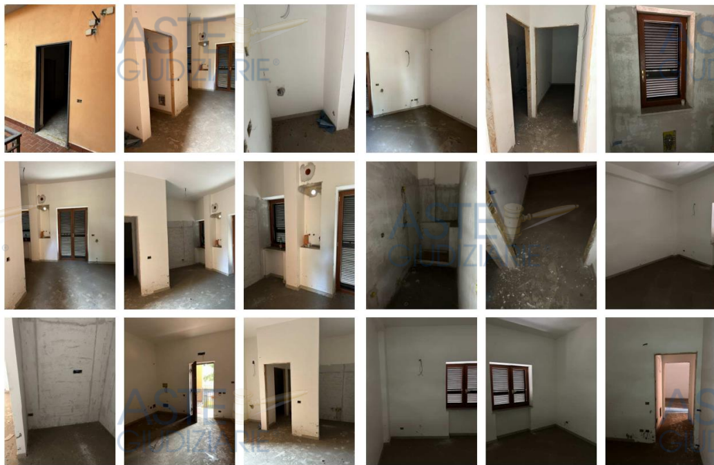
Estratto repertorio fotografico del sub 9
