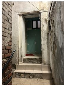
Foto 53 - Vano scala - verso il disimpegno comune d'accesso all'immobile pignionato sub 78
