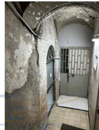
Foto 6 - Vano scala di accesso all'immobile pignonato
