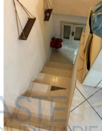
Foto 36 - Scala di accesso al soppalco
