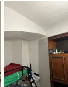
Foto 67 - SUB 78 - Ambiente n.2
