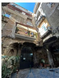
Foto 1 - Fabbricato in cui è ubicato l'immobile pignonato
