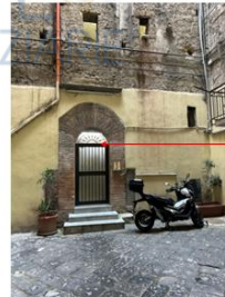
Foto 3 - Fabbricato in cui è ubicato l'immobile pignonato - ingresso al vano scala che conduce all'immobile pignonato
