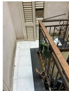
Foto 50 - SUB 77 - Balcone n.1
