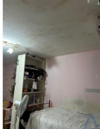
Foto 37 - Ambiente 1 su soppalco
