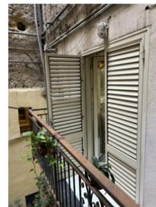
Foto 52 - SUB 77 - Balcone n.1
