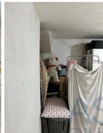
Foto 42 - Ambiente 2 su soppalco
