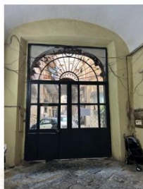
Foto 3 - Fabbricato in cui è ubicato l'immobile pignonato - androne
