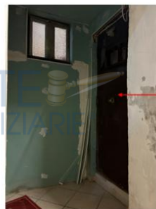
Foto 54 - Disimpegno comune d'accesso all'immobile pignionato sub 78 - ingresso al cespite
