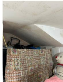
Foto 45 - Ambiente 2 su soppalco
