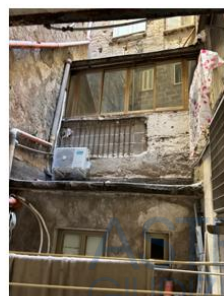
Foto 70 - SUB 78 - Vanella nella quale prospetta la finestra dell'Ambiente n.2
