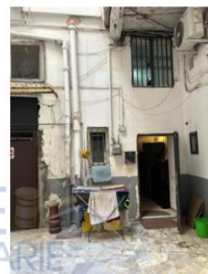
Foto 6 - Accesso all'immobile pignorato dal cortile
