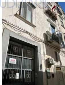
Foto 2 - Accesso al fabbricato dal Vico della Noce a Fonseca
