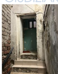
Foto 10 - Vano scala - verso il disimpegno comune d'accesso all'immobile pignonato
