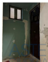
Foto 12 - Disimpegno comune d'accesso all'immobile pignonato - ingresso al ospite adiacente di cui al LOTTO 2
