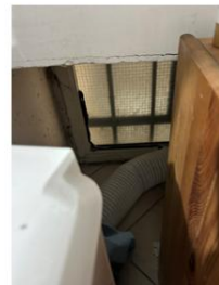
Foto 48 - Ambiente 2 su soppalco
