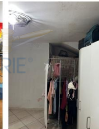
Foto 49 - Ambiente 2 su soppalco
