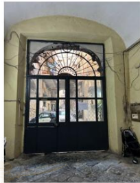
Foto 2 - Fabbricato in cui è ubicato l'immobile pignonato - androne
