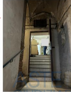
Foto 9 - Vano scala - accesso al sub 77
