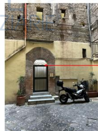
Foto 5 - Fabbricato in cui è ubicato l'immobile pignonato - ingresso al vano scala che conduce all'immobile pignonato
