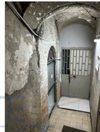
Foto 6 - Vano scala di accesso all'immobile pignonato
