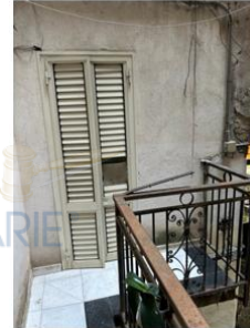
Foto 51 - SUB 77 - Balcone n.1
