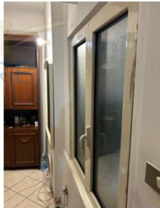
Foto 65 - SUB 78 - Ambiente n.2
