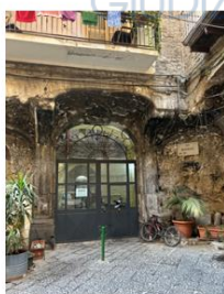
Foto 2 - Fabbricato in cui è ubicato l'immobile pignonato - ingresso
