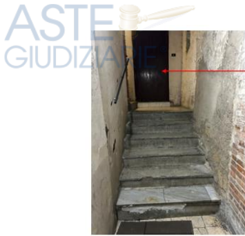
Foto 7 - Vano scala - accesso al sub 77
