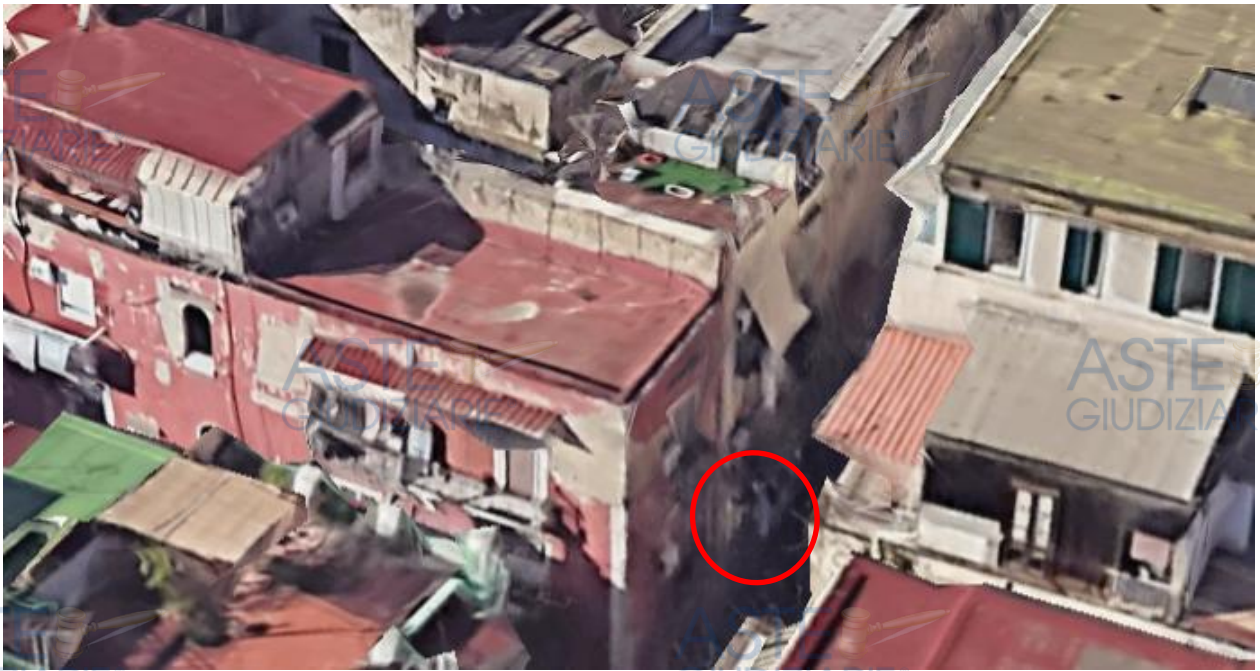
Foto 1 - Vista aerea con individuazione dell'immobile oggetto del pignoramento
