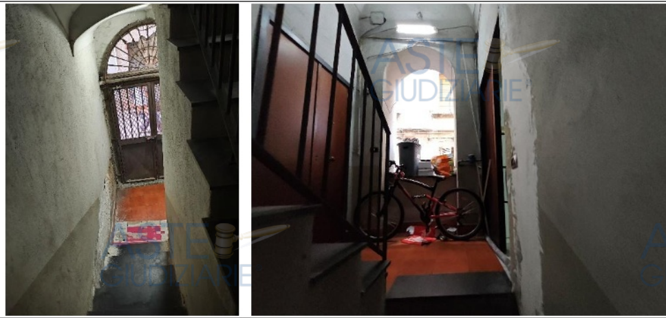
Foto n. 3/4 vista vano scala, ingresso
