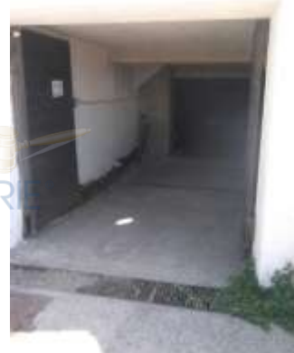
Rampa di ingresso al locale
