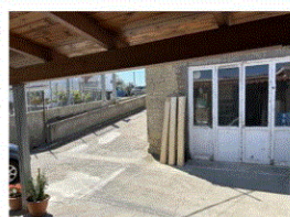
Foto n. 6 - Immobile verso la galleria di proprietà aliena
