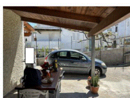
Foto n. 4 - Tettoia dell'immobile - verso l'ingresso
