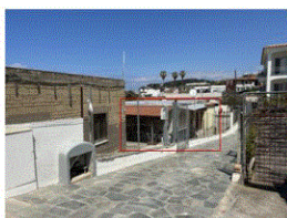
Foto n. 2 - Immobile pignorato dall'esterno
