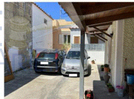
Foto n. 5 - Tettoia dell'immobile - verso l'ingresso
