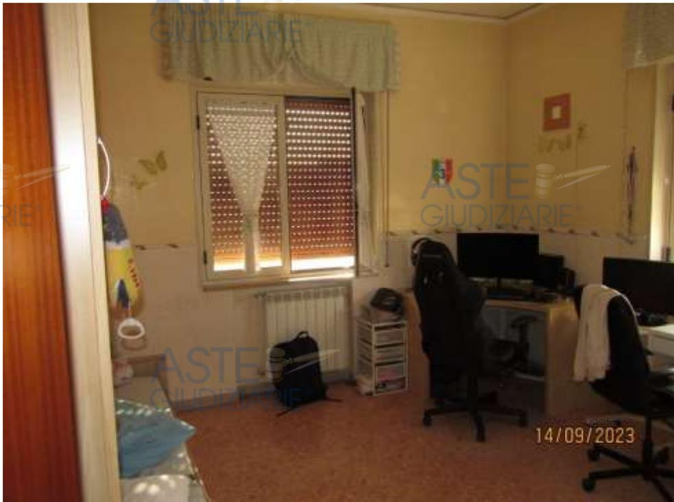
**Fotografia 29 – Vano 3: La pavimentazione è costituita per tutta la sua superficie da bollettonato in graniglia di marmo.**
