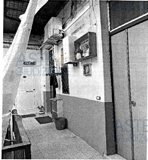
Foto 3 - Ingresso immobile dal pianerottolo
