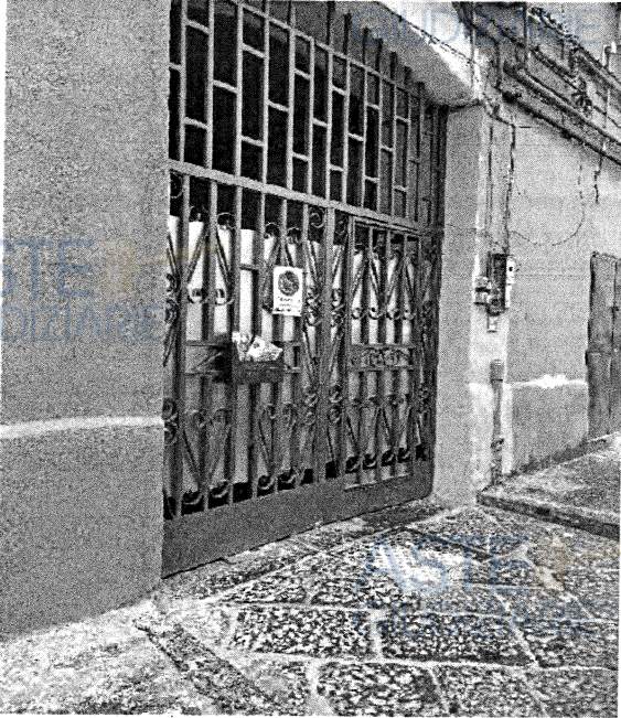
Foto 2 - Portone ingresso dell'edificio
