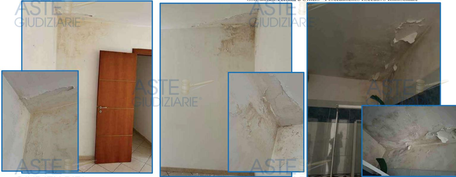
*Macchie di infiltrazione, efflorescenze saline, muffa, rigonfiamenti, bollature, esfoliazioni, de coesione e distacchi di pittura*
