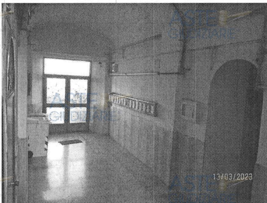
**Fotografia 10** – Le pareti dell'androne, risultano rivestite con lastre di marmo beige per un'altezza di circa un metro dal pavimento, mentre la restante parte sono intonacate e tinteggiate con pittura lavabile. Su una delle pareti sono installate le cassette postali degli appartamenti.
