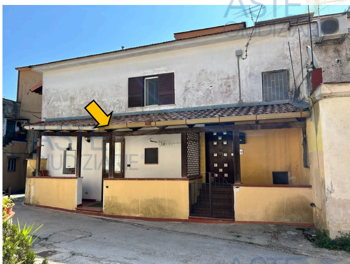
Veduta del fabbricato in cui è ubicata l'u.i. da Via Nazareth
