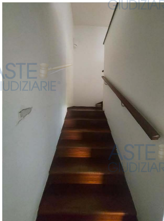
Scala che conduce al piano primo
