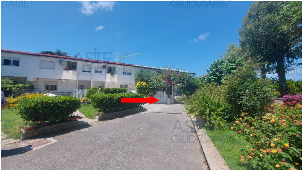
Prospetto nord-est - accesso pedonale cespite
