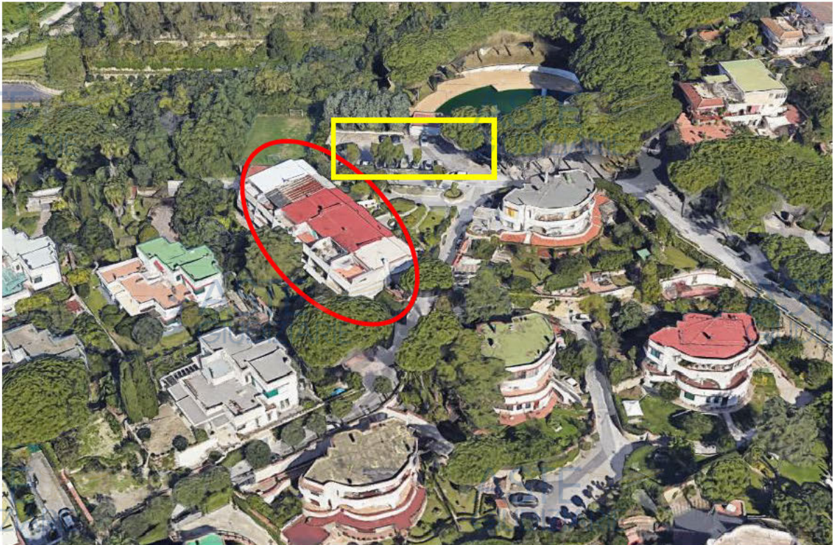
Inquadramento territoriale – indicazione fabbricato cespite (rosso) e piazzale adibito a parcheggio (giallo)
