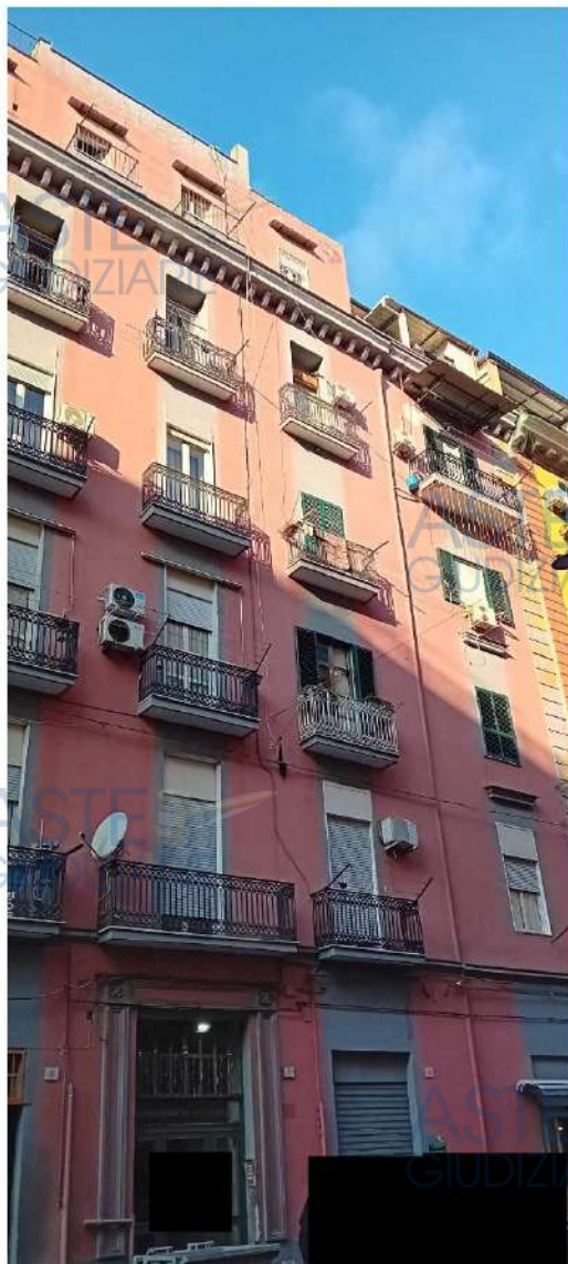
Foto 01 Facciata lato ingresso
