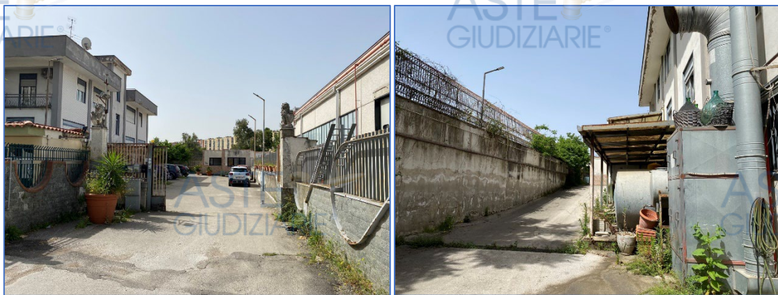
Figura 3. Varco di accesso sul confine nord e recinzione lungo il confine sud (degradante da ovest a est).
