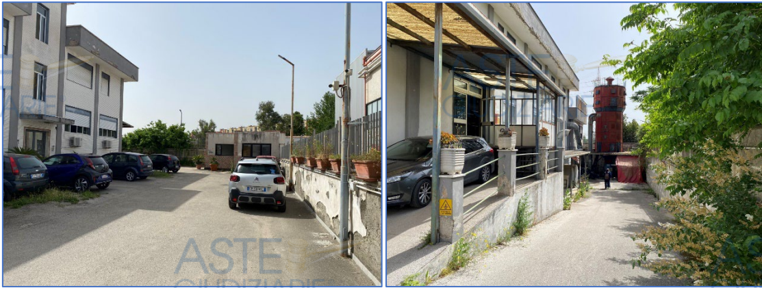
Figura 4. Area scoperta (porzione ovest antistante il fabbricato e porzione sud con silos nella parte terminale).
