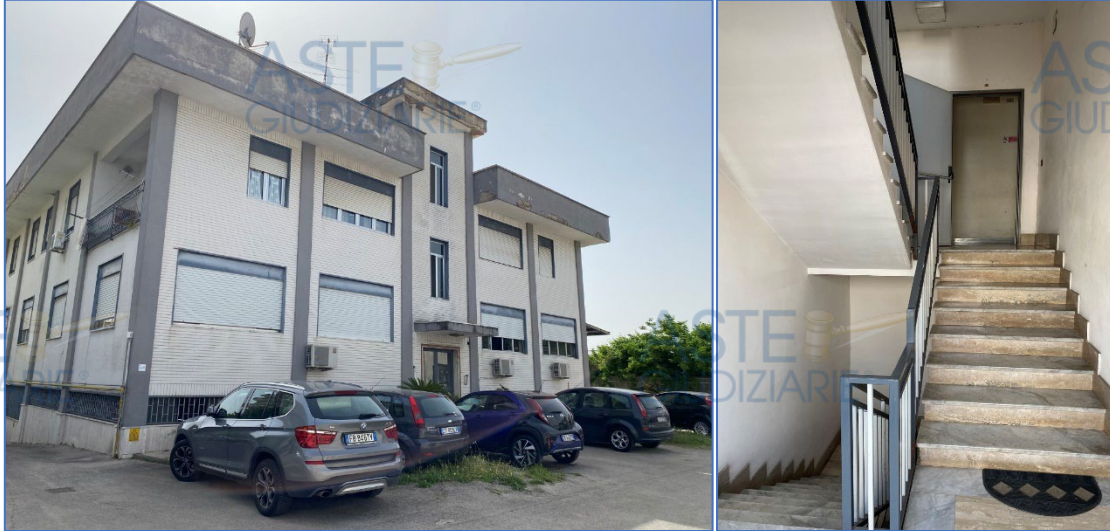
Figura 5. Prospetto principale del fabbricato e corpo scala ovest.
