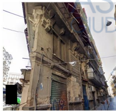
Foto n. 2 - Fabbicato in cui è ubicato l'immobile pignonato
