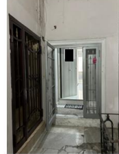
Foto n. 8 - Ingresso all'immobile pignonato dal vano scala
