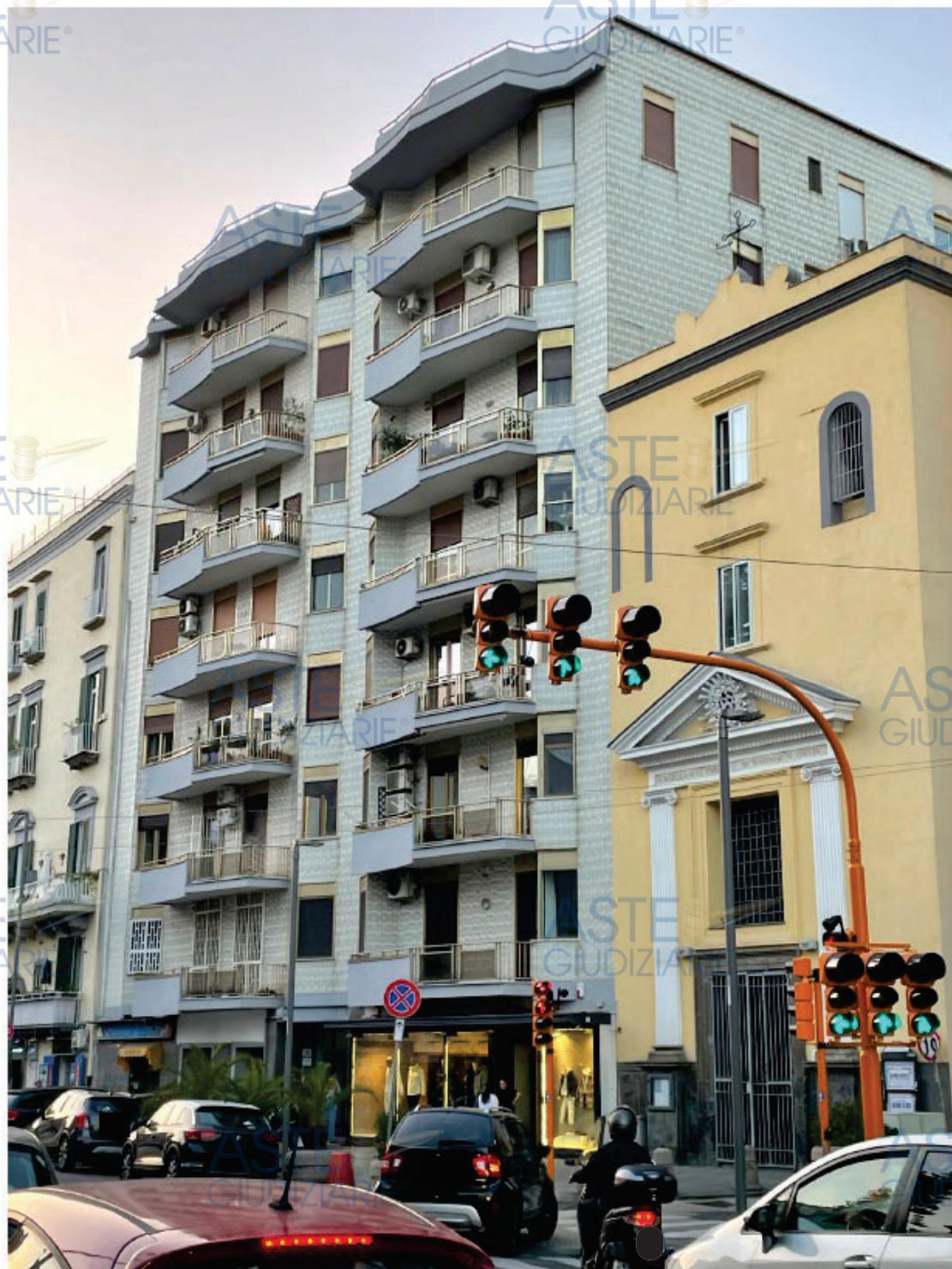
Facciata principale su via Riviera di Chiaia.
