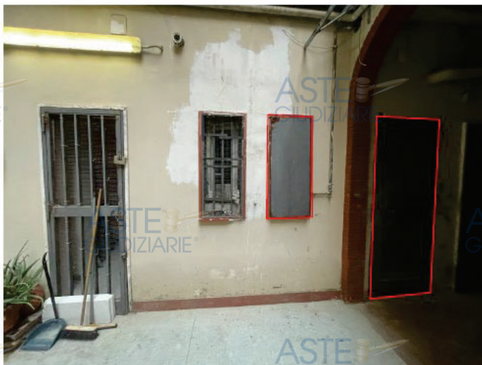
Si evidenziano i due infissi murati dall'interno.
