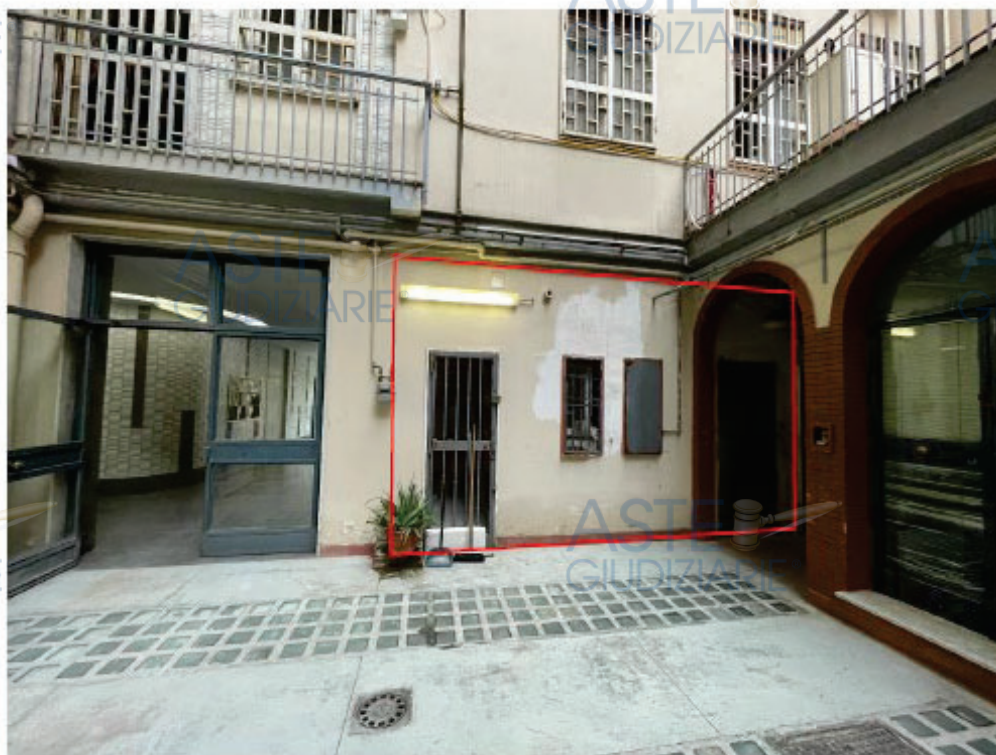
Cortile. Si evidenzia la facciata nord dell'immobile.
