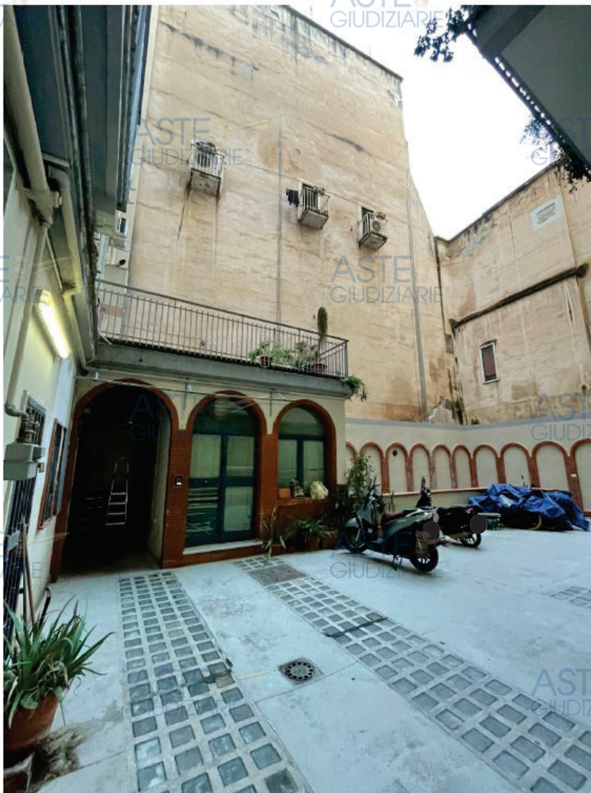
Cortile interno del fabbricato
