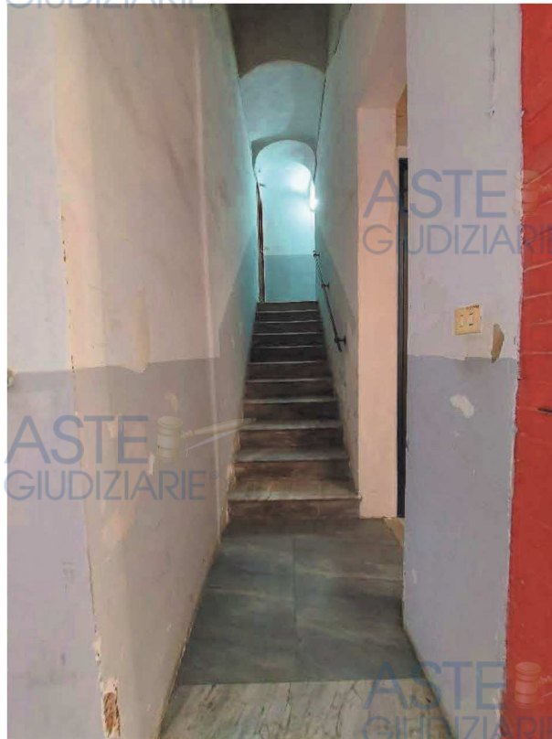
vano scala cespite
