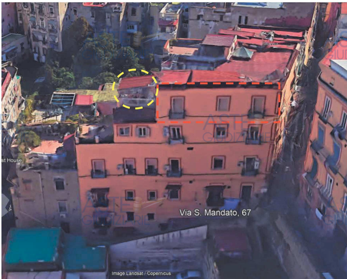
prospetto nord-ovest fabbricato –Gradini san Mandato - indicazione affacci cespite (rosso) e terrazzo (giallo)
