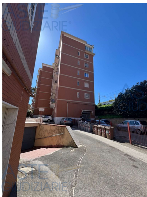
Foto 2. Esterno fabbricato vista dal cancello di ingresso
