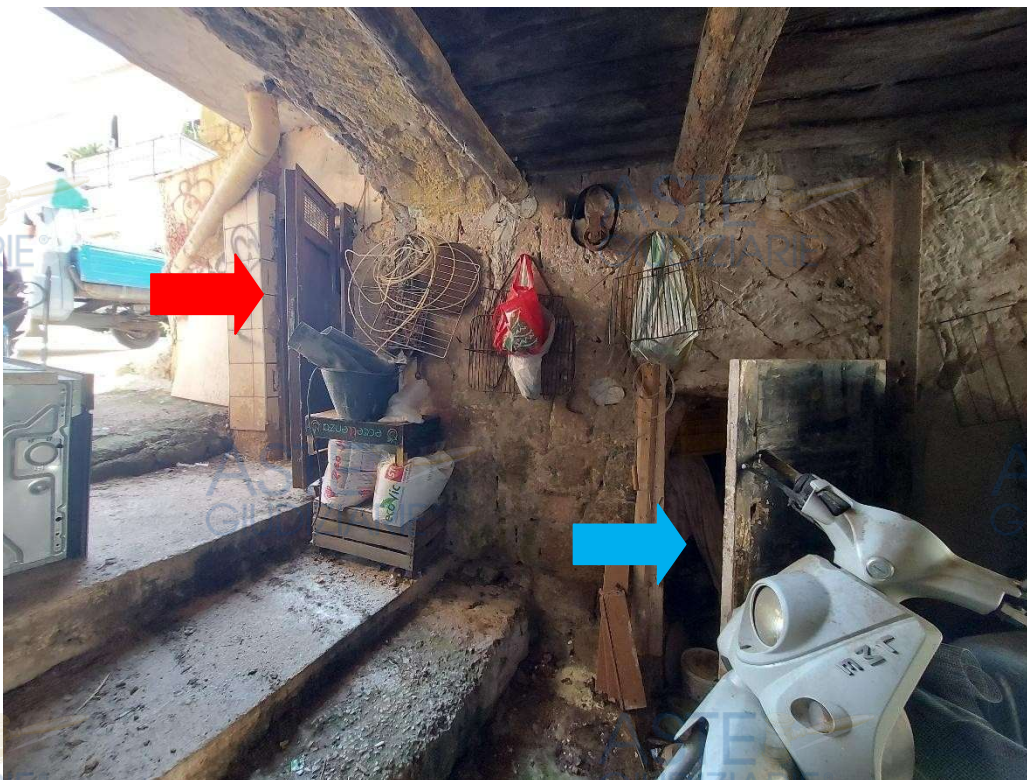
Porta accesso locale 1 ( rosso) locale 2 (celeste)
