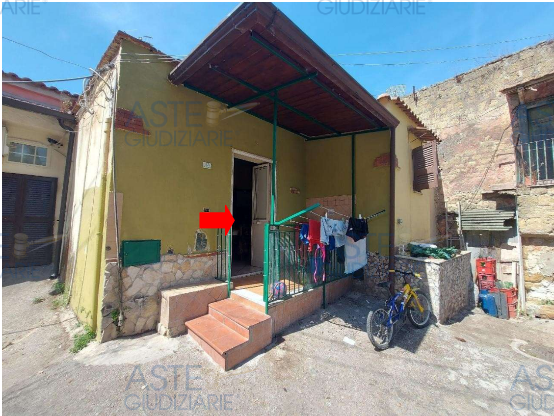
Spazio esterno di pertinenza e porta di accesso cespite civ.75
