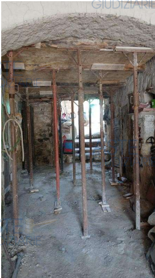
Messa in sicurezza solaio post intervento
