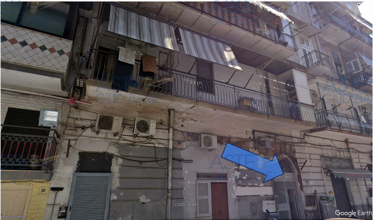
Particolare del fronte di ingresso del fabbricato si individua l'accesso al fabbricato (Google Earth)
