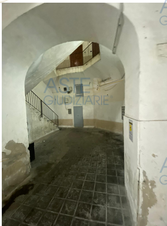
Particolare dell'accesso alla Scala B
