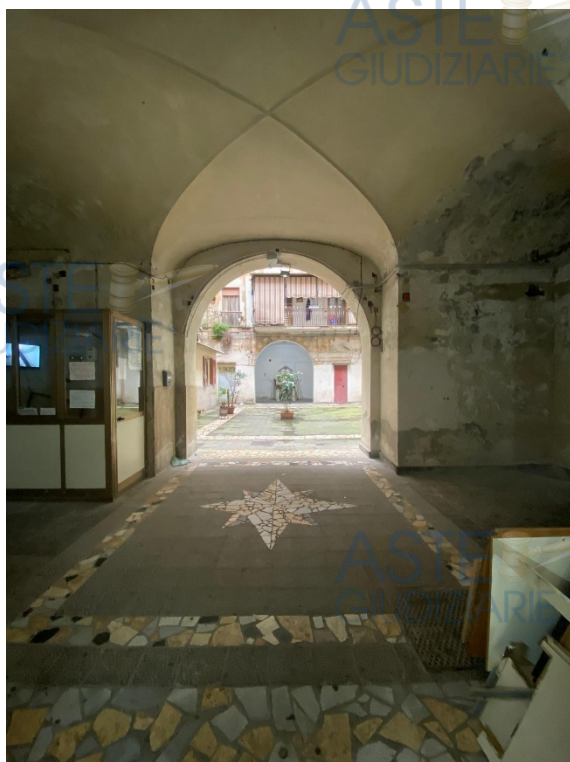
Particolare dall'ingresso al fabbricato
