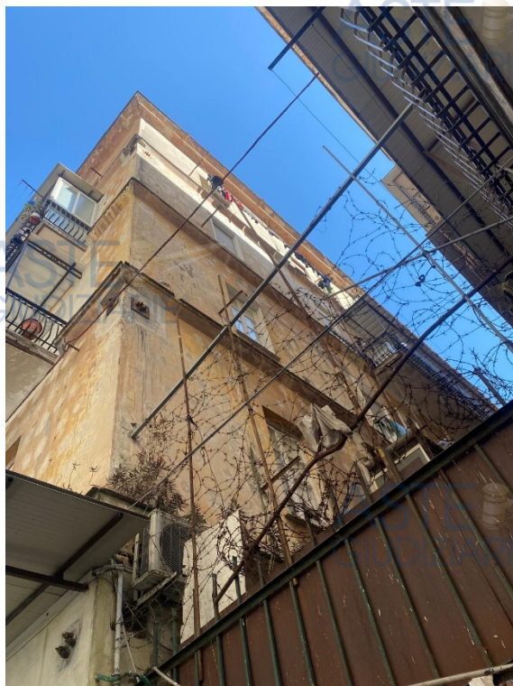
Particolare del fronte laterale del fabbricato prospettante su intercapedine si individua l'affaccio dell'immobile staggito
