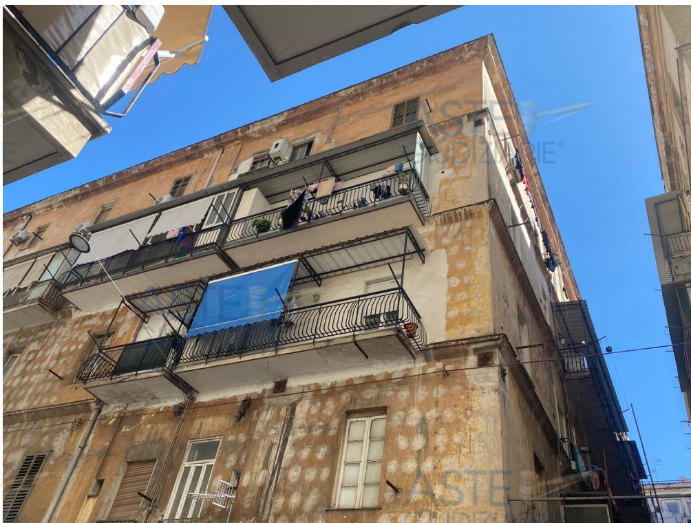
Particolare del fronte posteriore del fabbricato prospettante su via S. Cosmo si individua l'affaccio dell'immobile staggito
