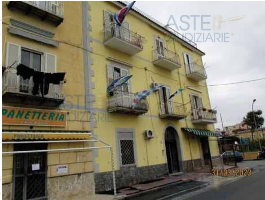
Fotografia 7 – Altra vista del Fabbricato da Via Lungolago.
