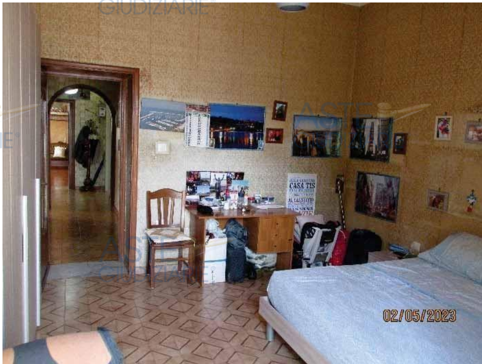
Fotografia 36 – Vano 3: Risulta adibito come camera da letto ed è interamente pavimentato con piastrelle in ceramica smaltata; presenta le pareti rivestite con intonaci ordinari a finitura liscia e decorate con carta da parati; il soffitto risulta interamente rivestito con intonaci ordinari a finitura liscia e tinteggiato con pittura a tempera.
