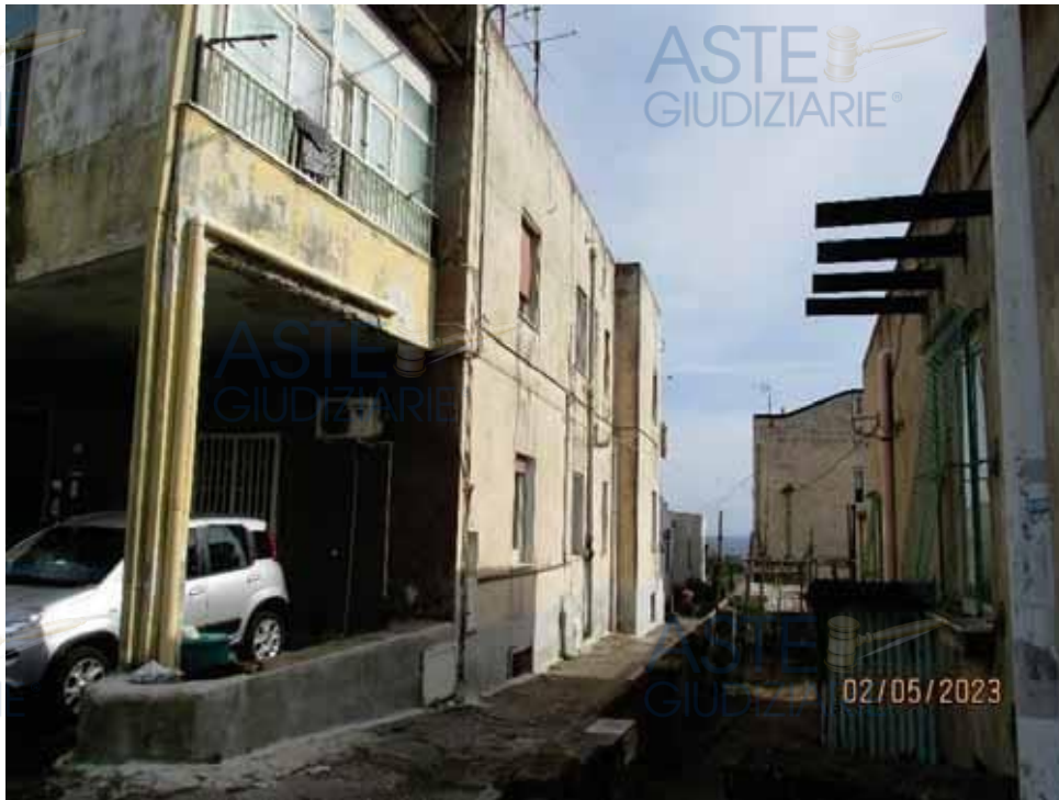
Fotografia 8 – Vista del Fabbricato dal viale privato sul versante ovest.
