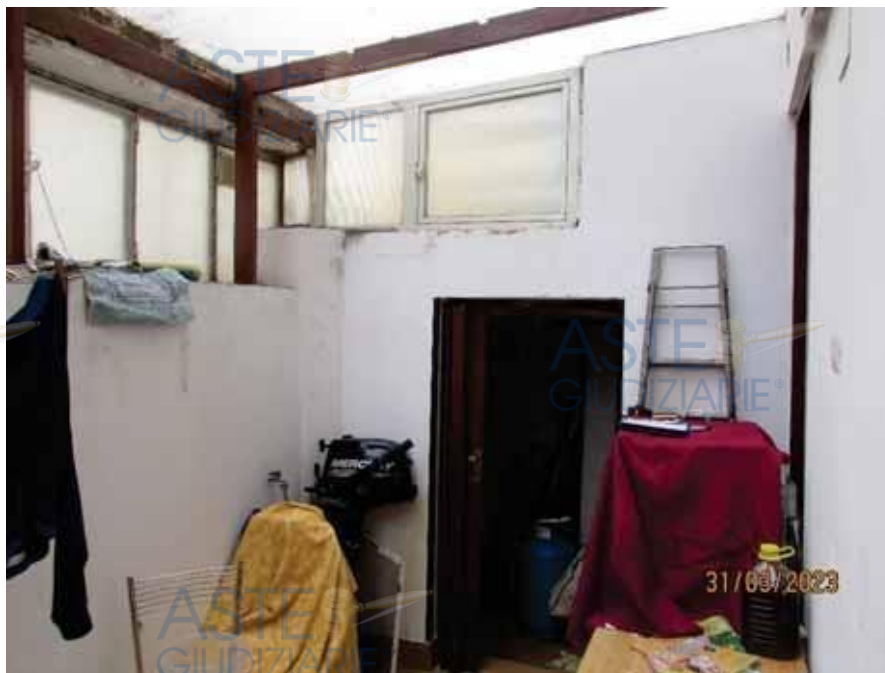
Fotografia 36 – Corte esclusiva: la parte terminale della parete perimetrale esterna, dispone di una struttura in ferro che lungo tutto il perimetro costituisce una chiusura d'ambito composta da finestroni in ferro con pannelli in plexiglass alveolari trasparenti opachi; anche l'intera copertura della corte è costituita da una tettoia composta da una struttura in ferro su cui sono poggiate delle lastre in plexiglass trasparente opache.
