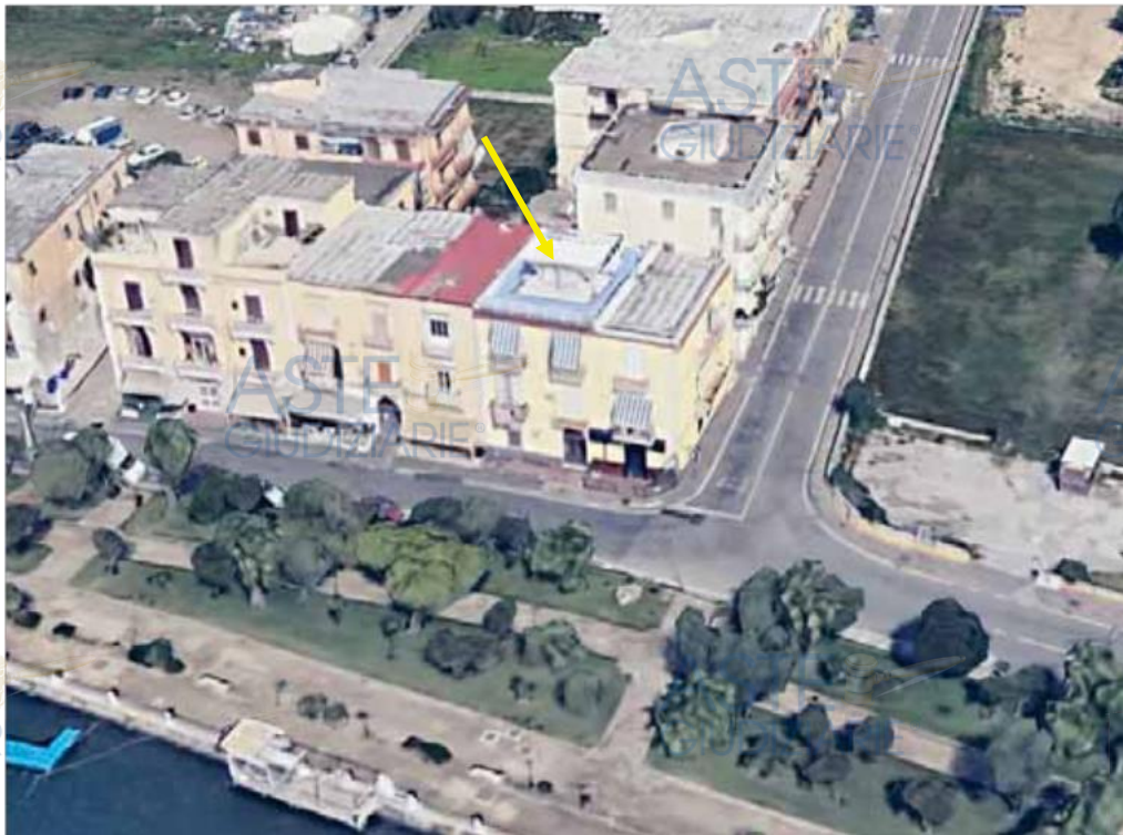
Fotografia 2 – Inquadramento territoriale lato Sud.
