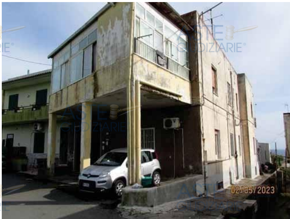
Fotografia 7 – Altra vista del Fabbricato da Via Solferino.
