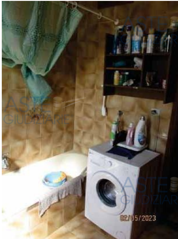
Fotografia 31 – Bagno 1: Risulta pavimentato con piastrelle in ceramica smaltata; anche le pareti sono rivestite a tutta altezza con piastrelle in ceramica smaltata; il soffitto è rivestito con intonaci ordinari a finitura liscia e tinteggiato con pittura a tempera.
