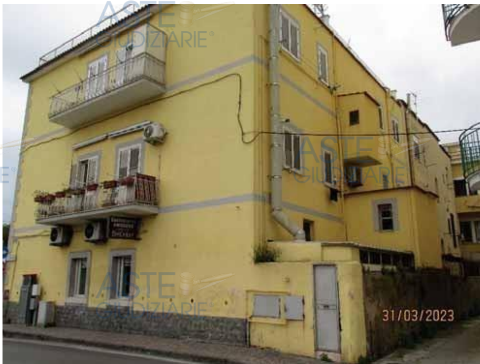
Fotografia 8 – Vista del Fabbricato da Via Risorgimento.
