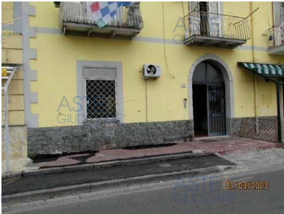
Fotografia 9 – Vista del varco d'ingresso al Fabbricato.
