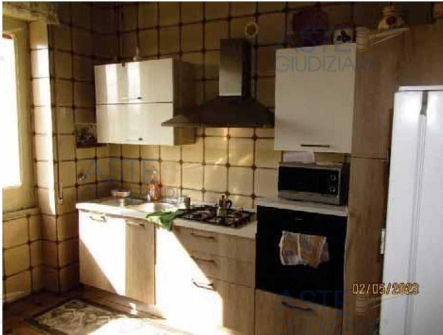
Fotografia 23 – Cucina: le pareti sono interamente rivestite con piastrelle in ceramica smaltata; il soffitto risulta rivestito con intonaci ordinari a finitura liscia e tinteggiato con pittura a tempera.
