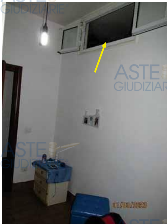
Fotografia 22 – Vano 2: Nella parte alta della parete divisoria con il “Vano 1”, a circa ml. 2,50 dal pavimento è installata una finestra avente altezza di circa ml. 0,50 apribile per consentire l'aerazione dell'ambiente poiché risulta privo di finestrate verso l'esterno.
