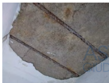
Soffitto della cucina
