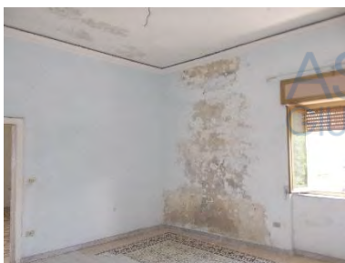
Finestra e parete della prima camera
