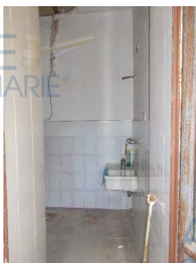
Rivestimento e pavimento della cucina
