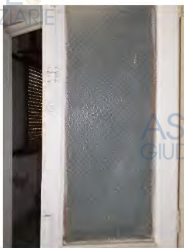
Dettaglio delle porte interne
