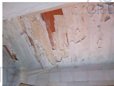
Soffitto del bagno
