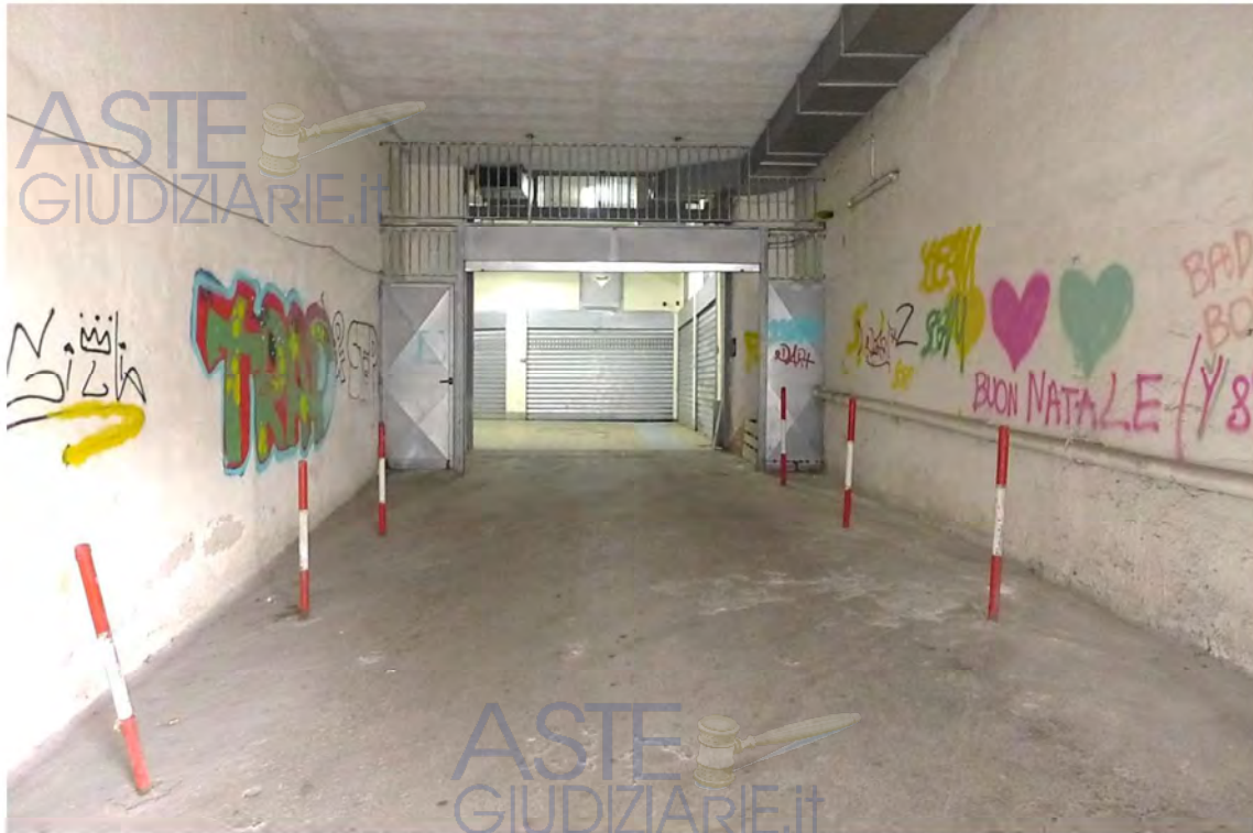
Corridoio d'accesso ai locali garages fabbricato "Ametista"
