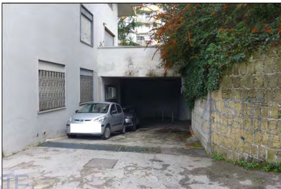
Rampa d'accesso ai locali garages fabbricato "Ametista"
