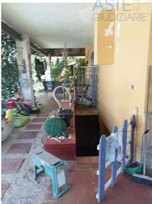
Accesso a piano seminterrato
