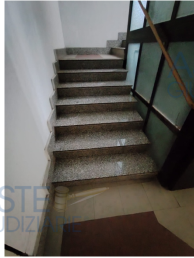
Vano scale edificio
