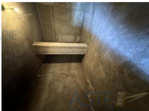
Particolare interno: locale deposito - magazzino
