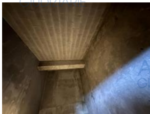
Particolare interno: locale deposito - magazzino
