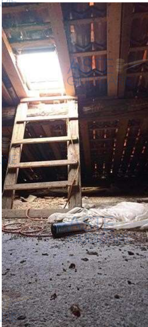
porzione di sottotetto soprastante i subalterni 716 717 e 718
