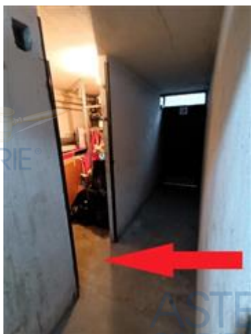
situazione rilevata della cantina
