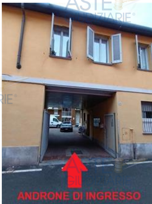
ingresso dalla strada tramite androne comune
