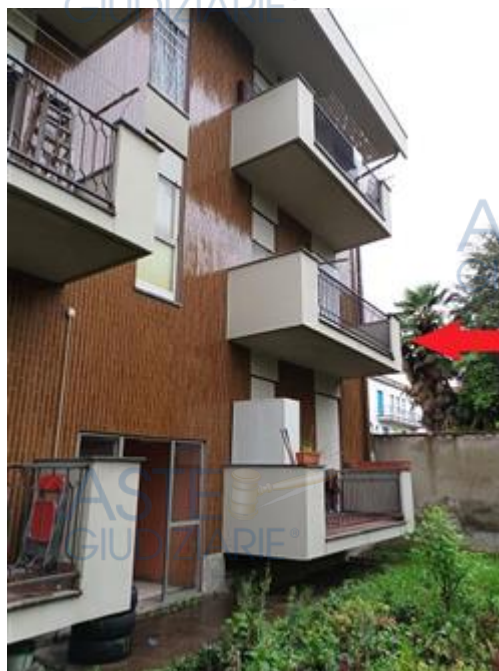
facciata a lato nord
